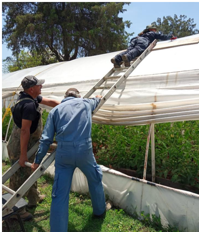
Fotografía 3. Colocación de parches plásticos en las cubiertas rotas.
