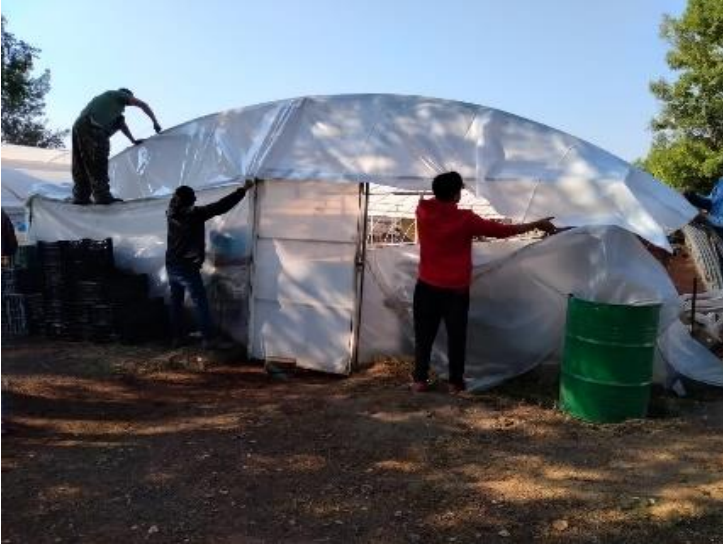
Fotografía 1. Cambio de cubierta plástica del túnel 1.
