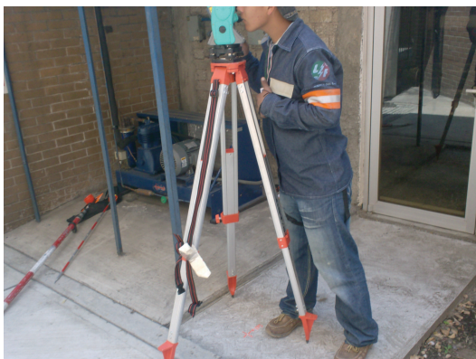
Imagen 3. Trabajos topográficos en el sitio
