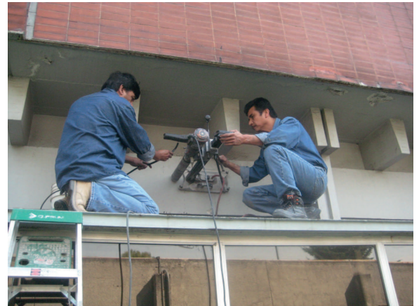
Imagen 6. Extracción de corazones de concreto
