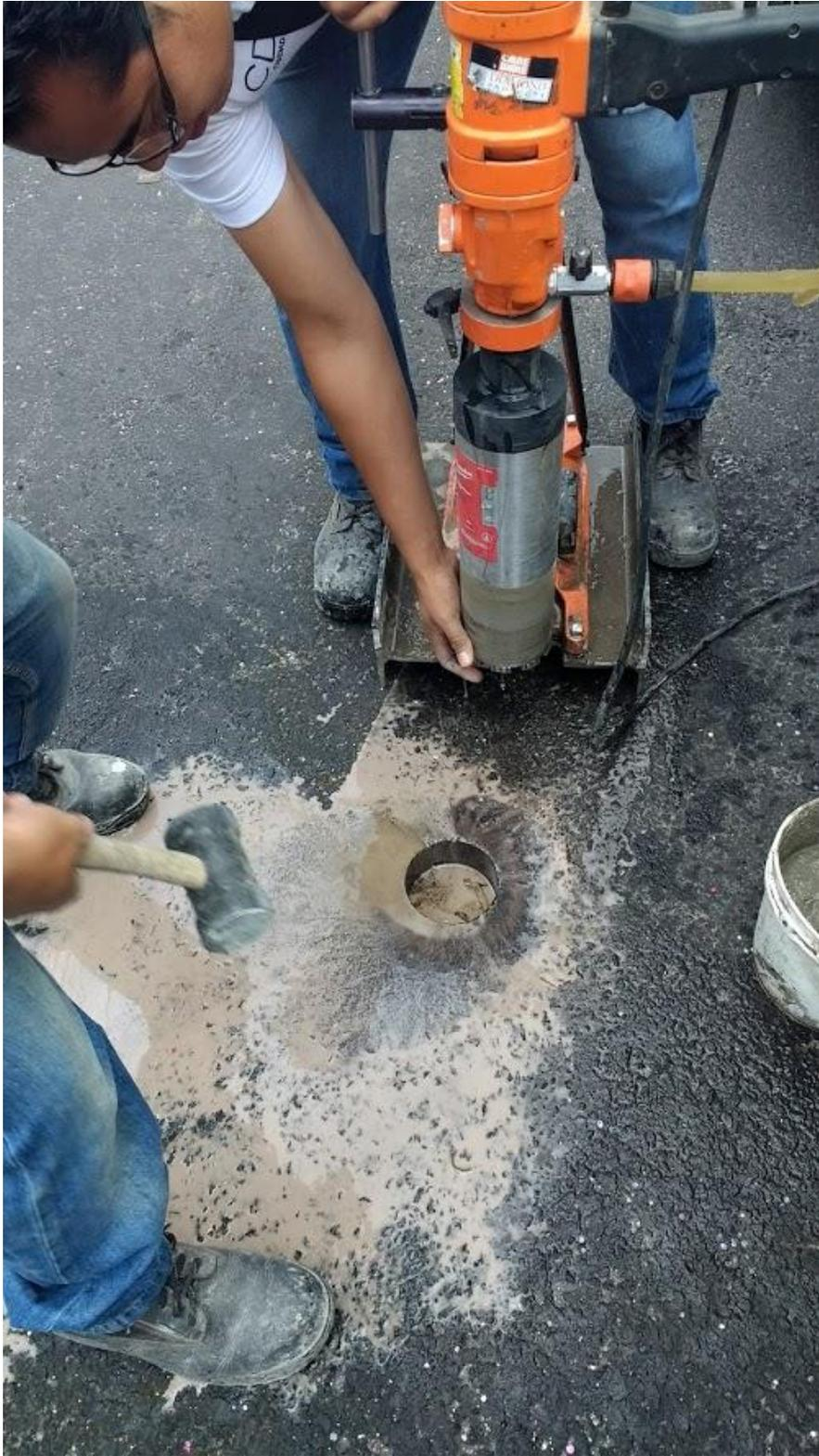
Extracción de carpeta asfáltica para revisión de espesores con Supervision interna, externa de la delegación y Supervisor de Obra de la empresa ganadora.
