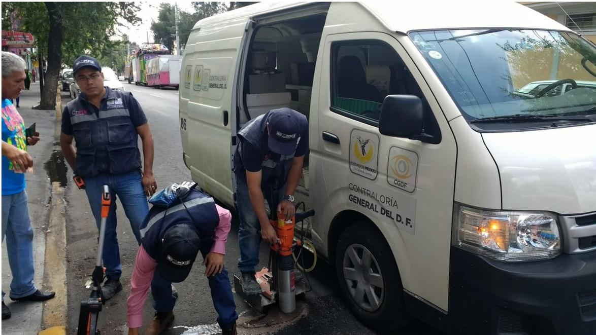
Extracción de carpeta asfáltica y medición de cales con distanciómetro en la Col. Guerrero en Septiembre del 2017.
