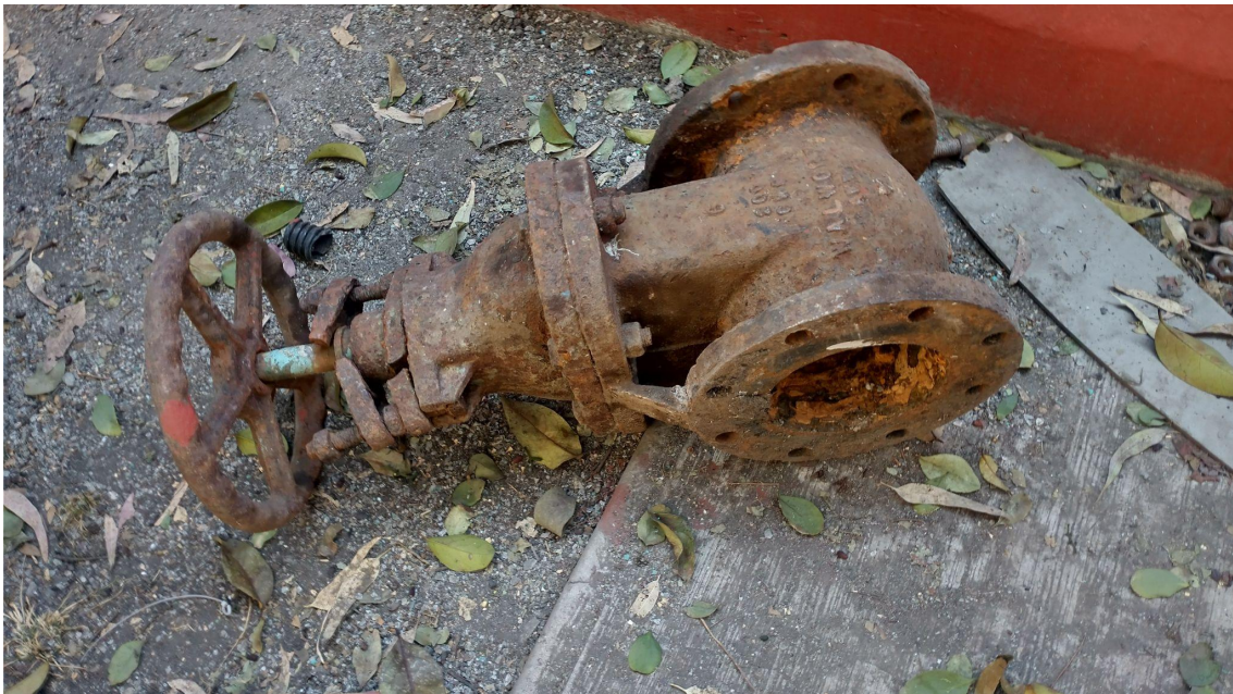
Sustitución de válvulas en U.H. CTM VII (Imagen 02)
