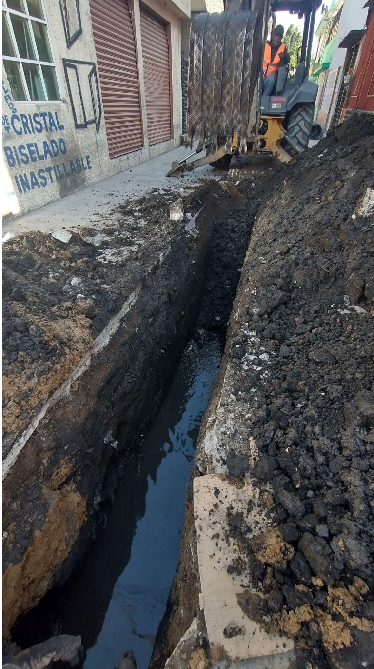
excavación para desplante de tubería de 18" para obra hidrosanitaria (Imagen 04)
