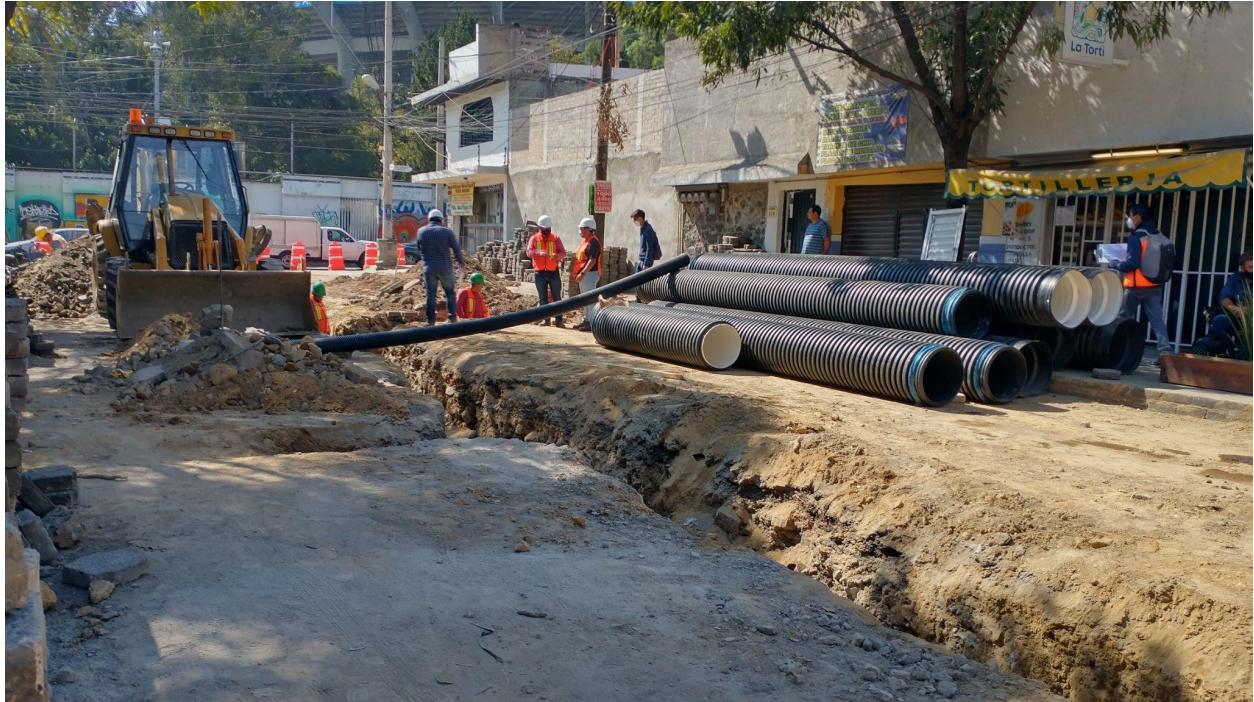
Alcantarillado y saneamiento en calle "hidalgo" ( Imagen 05 )
