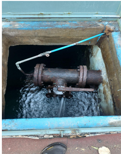
Mantenimiento de válvula "check" 12" en CROC secc. VI ( Imagen 05 )
