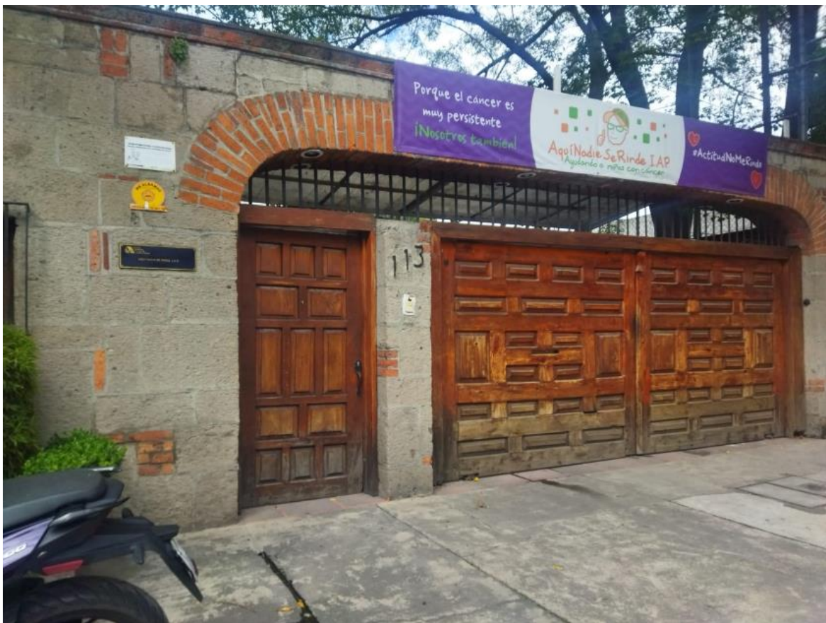
Imagen 2. Fachada principal del Centro ANSeR.
