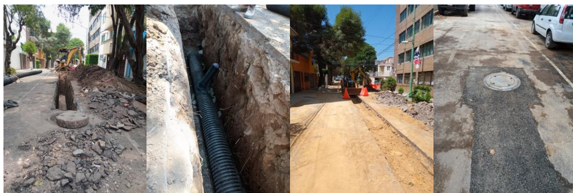
Fotografías 1-4 Drenaje calle Fernando Anaya Monroy.
