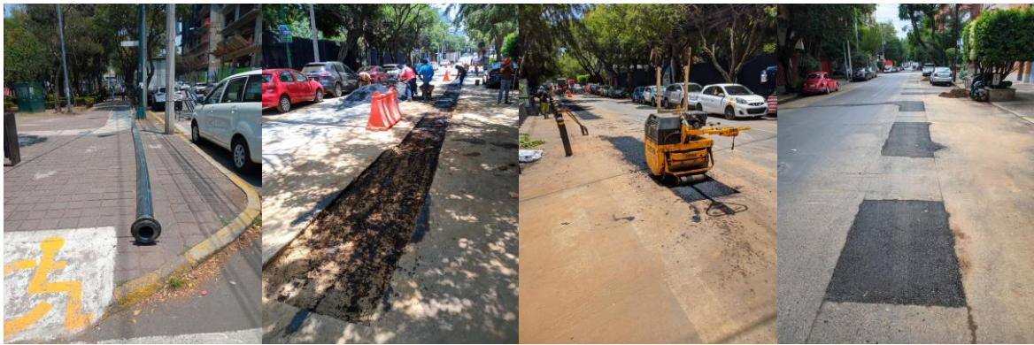
Fotografías 5-8 Agua potable calle Morena.
