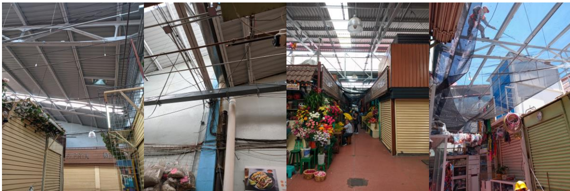
Fotografías 17-20 Rehabilitación del Mercado San Lázaro.
