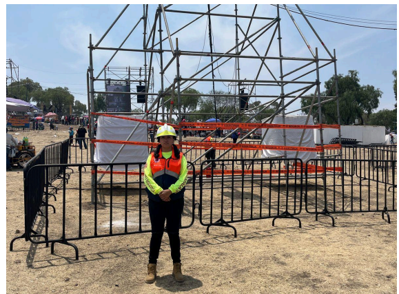
Imagen 6: Custodiando estructura temporal. Fotografía tomada por personal de Protección Civil
