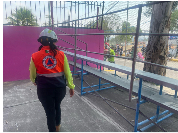
Imagen 4: Observando estabilidad de estructura de acero. Fotografía tomada por personal de Protección Civil
