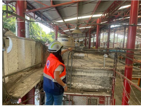
Imagen 2: Inspeccionando instalación eléctrica. Fotografía tomada por personal de Protección Civil
