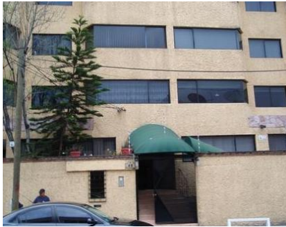
FACHADA PRINCIPAL DEL INMUEBLE
