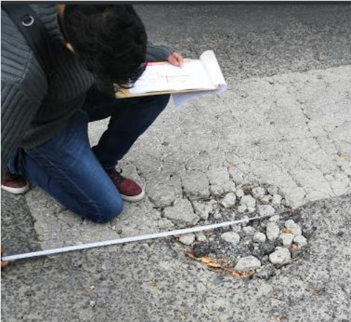
Imagen 1 Levantamiento de baches existentes en estacionamiento UAM-XOCHIMILCO.
