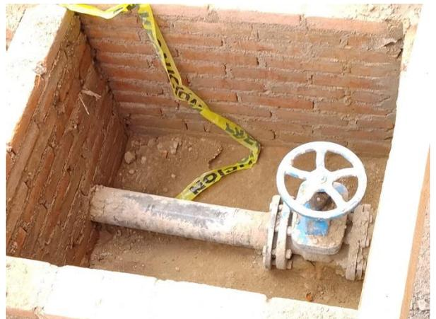
Fotografía 9: Caja y válvula terminada.
