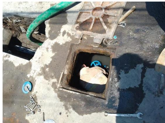
Fotografía 6 y 7: Instalación de válvulas en colonia Viejo Ejido en instalación hidráulica.
