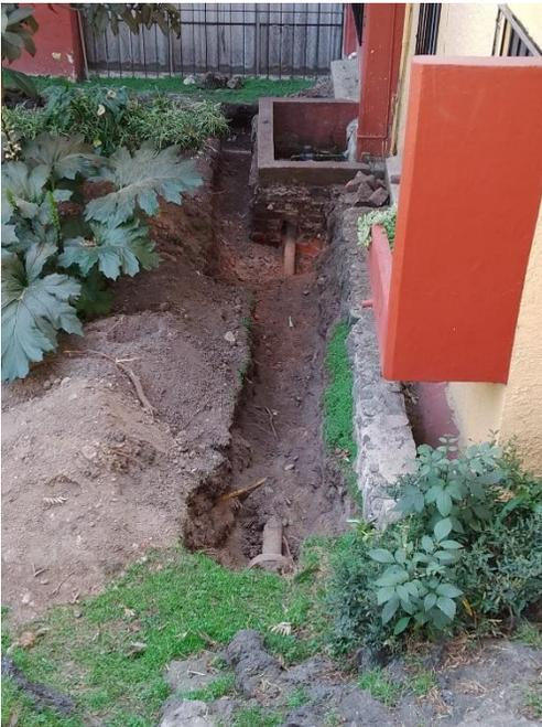
Fotografía 4: Excavación y localización de tubería a cambiar
