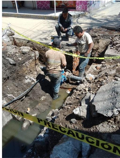
Fotografía 2: Tomada en visita a obra en la cual se llevó a cabo la corrección, cambio de tubería vieja de agua potable por una nueva de poliuretano de alta densidad e instalación de válvulas check
