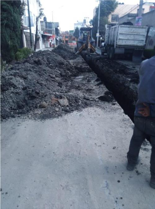
Fotografía 1: Tomada en visita a obra en la cual se llevó a cabo la sustitución de un tramo de línea de drenaje de asbesto por una nueva de poliuretano de alta densidad.
