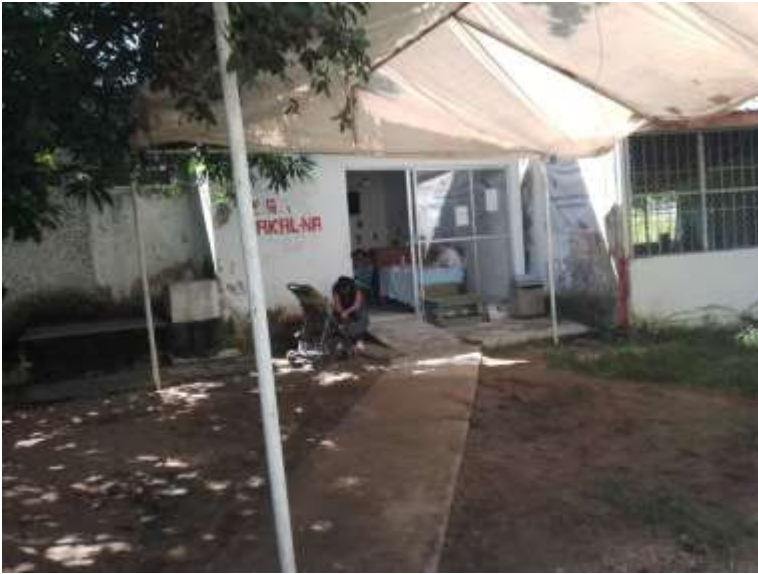
Imagen 10. Fachada del Centro de Salud de Pakalná (EPSS De la Cruz, 07/01/2024).
