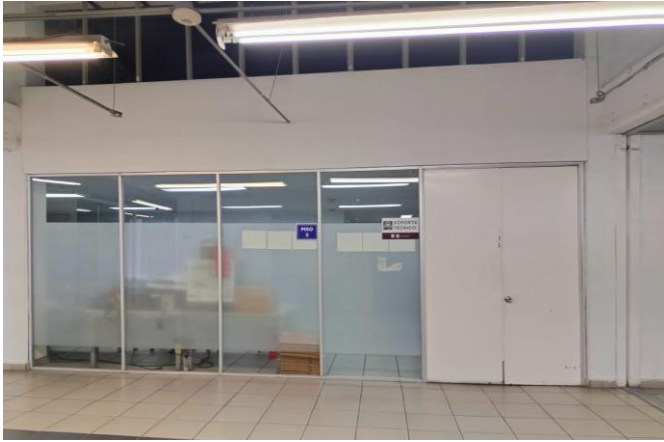
IMAGEN 9. ARCHIVO FOTOGRAFICO // ESTADO ACTUAL FACHADA PRINCIPAL ÁREA DE SOPORTE TÉCNICO
