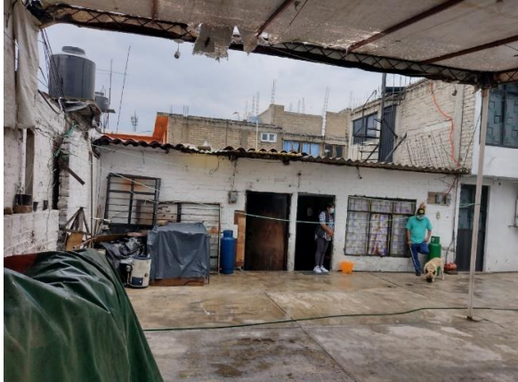
Vivienda provisional por demoler.
