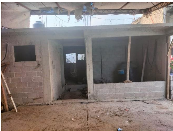
Fachada de vivienda nueva, primer nivel.
