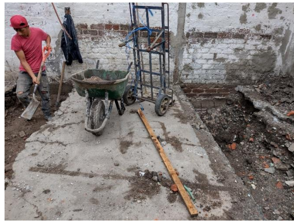
Zanjas para cimentación.
