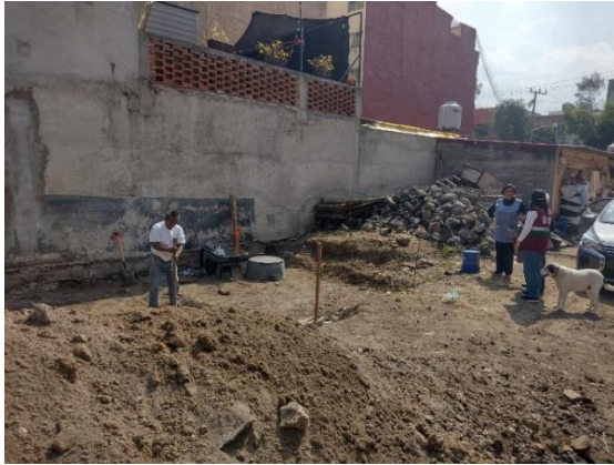
Demolición de viviendas provisionales.
