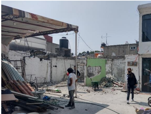
Demolición de vivienda provisional.
