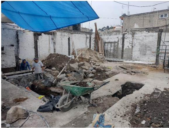
Excavación para iniciar cimentación.
