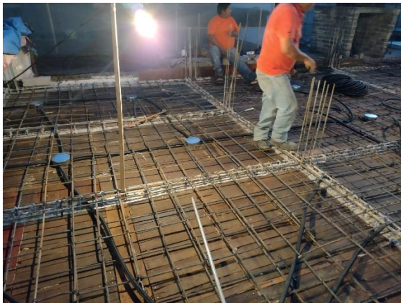
Cimbra y armado de losa.
