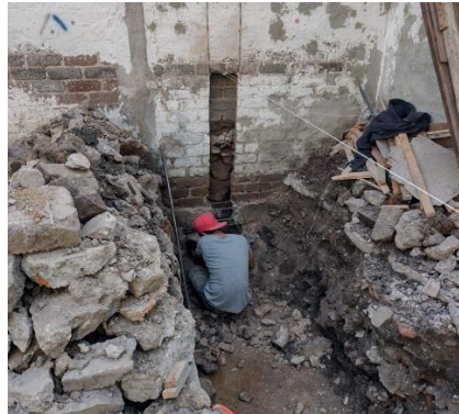
Excavación para cimientos.
