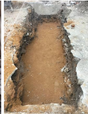
Zanjas para zapatas.
