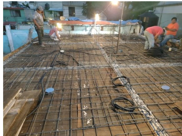
Armado de losa y tubería eléctrica.
