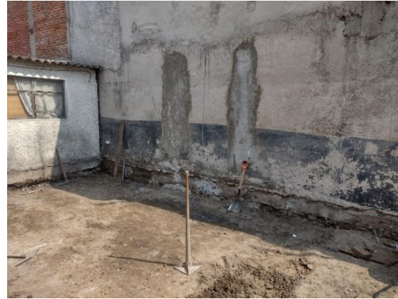
Preparación de terreno para cimentación.
