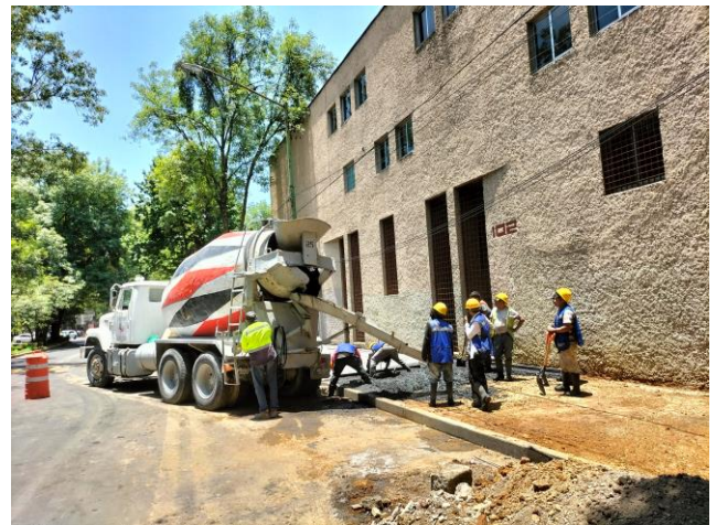
Imagen 06. Reporte fotográfico de la colocación de concreto.
