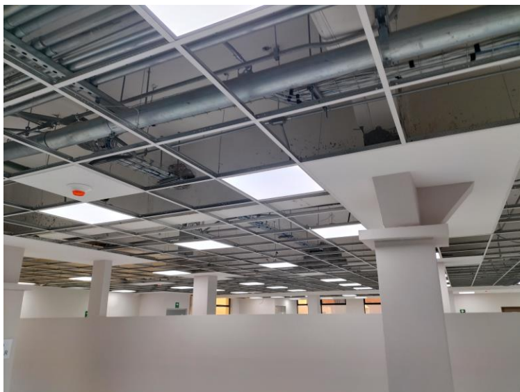
Imagen 10. Renovación de falso techo en las oficinas de la delegación Coyoacán.
