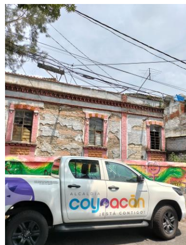
Imagen 09. Visita al centro de Coyoacán para realizar actividades de seguridad ciudadana.
