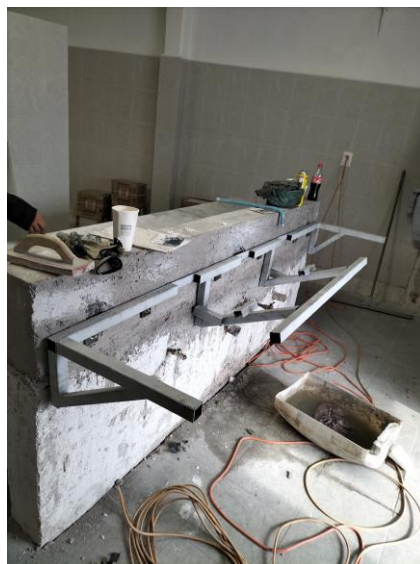
Imagen 11. Renovación de lavabo en el campamento de limpia.
