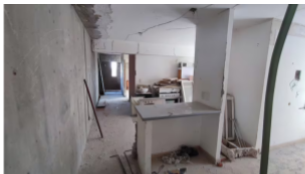
"Depto. interior Tlalpan 550" (CDMX, 2024), [Propia], Depto. en trabajo de rehabilitación
