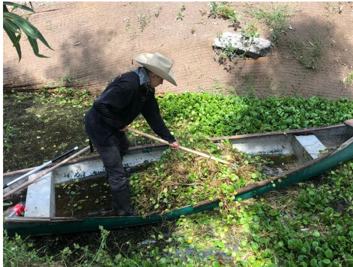
Figura 22. Limpieza de canal interno y extracción de tamborcillo.
