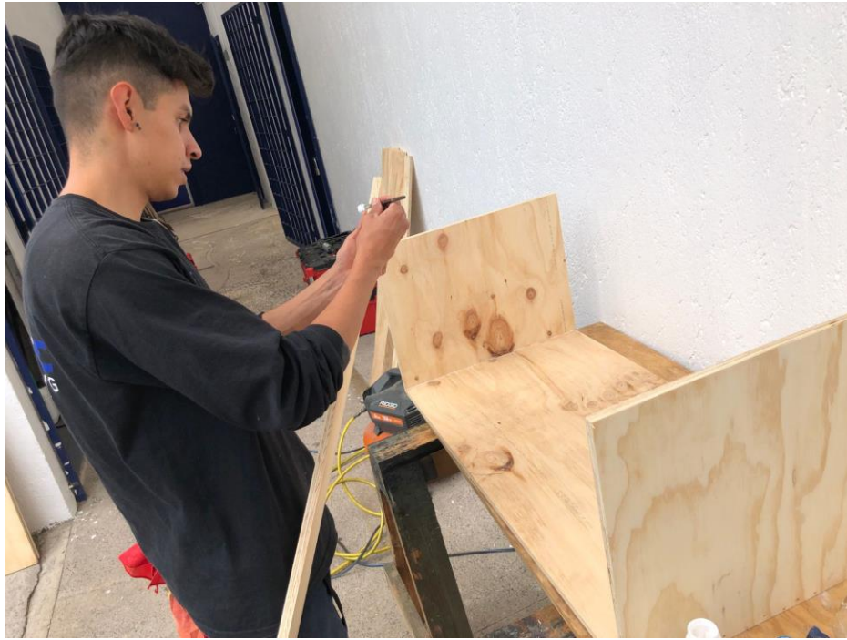
Figura 5. Medición del marco de madera para cortar.
