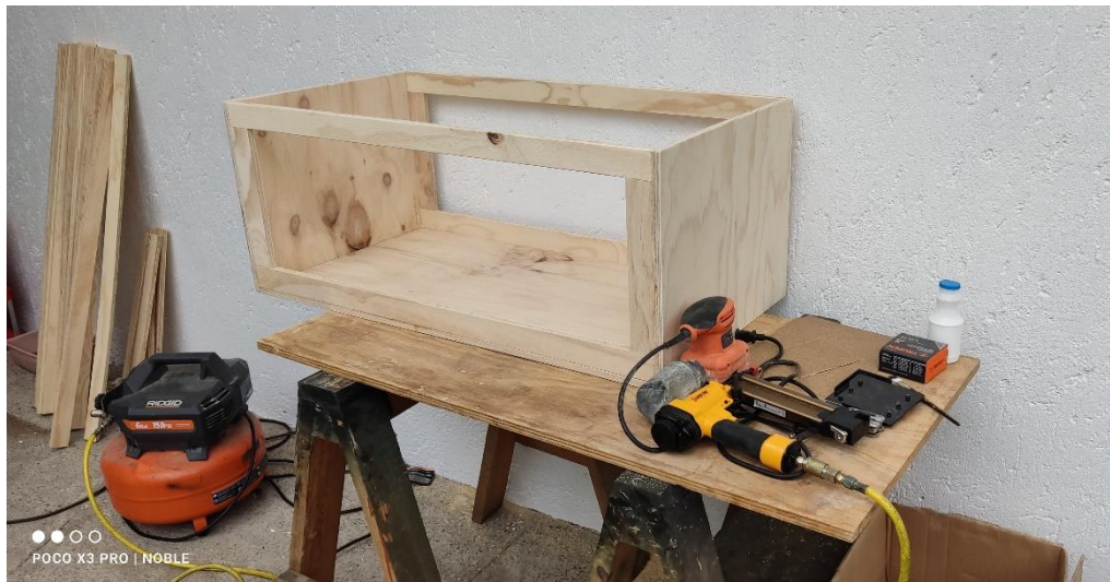
Figura 6. Base estructural del acuario armada y lijada para proceder a sellarla y ponerle vidrio templado y fibra de vidrio.
