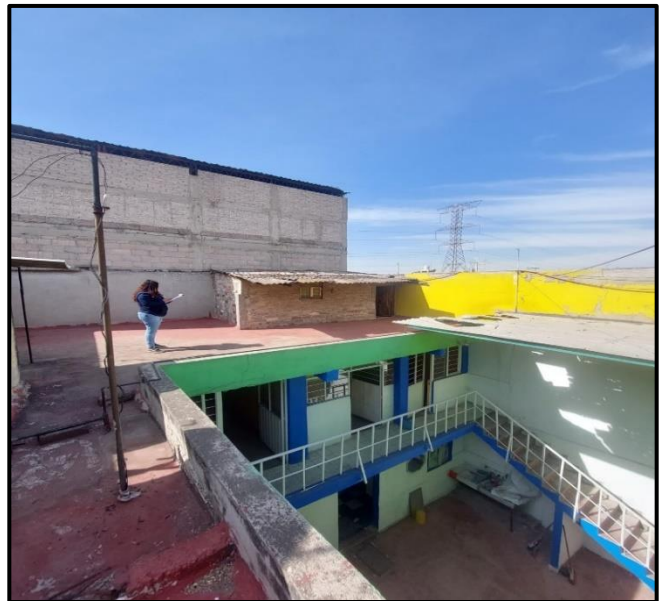
Imagen 16. Cubo de luz con vista desde azotea. Fuente: Fotografía propia febrero 2023
