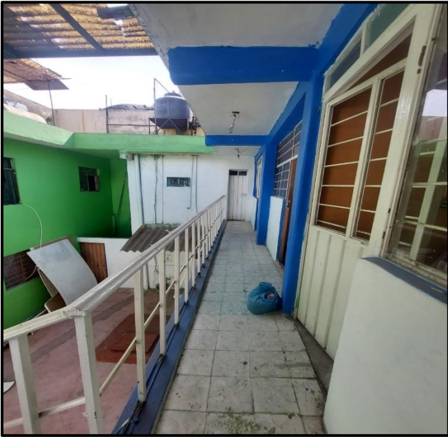
Imagen 13. Vestíbulo de planta alta con acceso a recámara, bodega y escalera de azotea. Fuente: Fotografía propia febrero 2023
