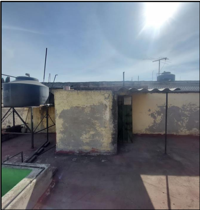
Imagen 17. Bodega con cubierta de lamina Fuente: Fotografía propia febrero 2023
