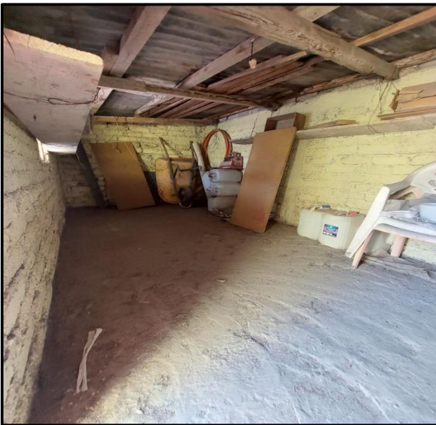
Imagen 19. Bodega con cubierta de lamina Fuente: Fotografía propia febrero 2023
