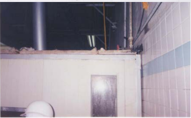
OXIDACION EN TUBERIAS.
