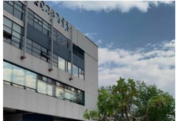
Anexo 6. Instalaciones de CONABIO, donde se realizó el servicio social.
