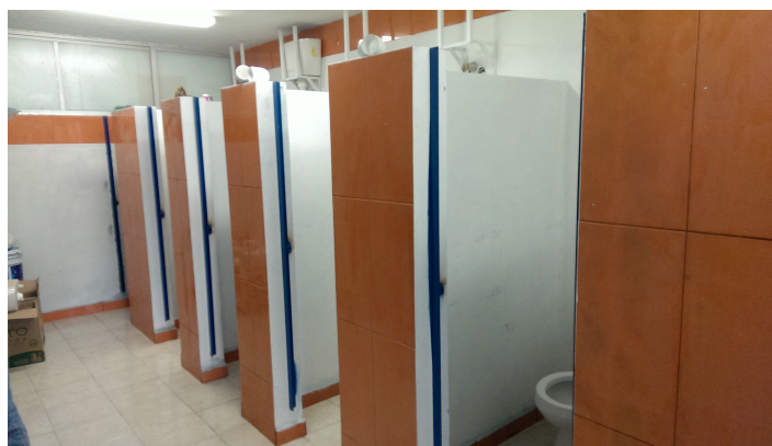
Imagen 13. Sanitarios de mujeres con excelente avance de remodelación.
