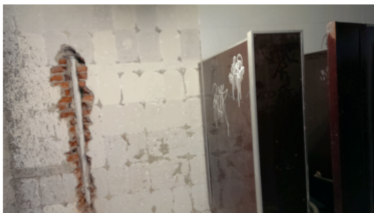
Imagen 14. Sanitarios de hombres en remodelación, nótese la demolición de azulejo en muro y pared para el cambio de tuberías.
