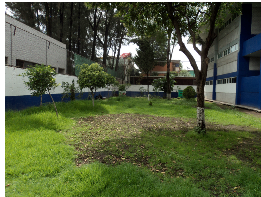
Imagen 2. Fachada posterior norte edificio B y área verde a intervenir.
