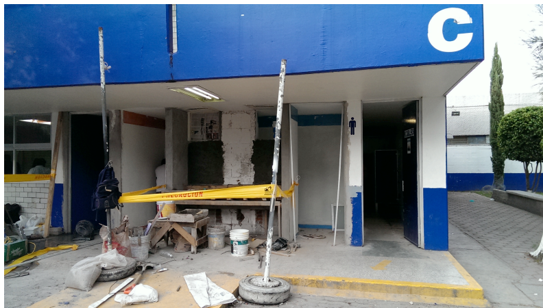
Imagen 12. Trabajos de remodelación en los sanitarios principales.
