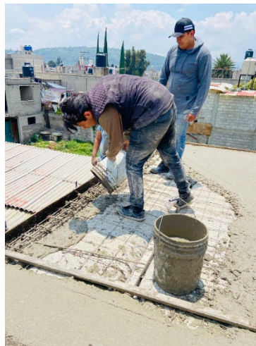
Imagen 27.- Foto de colado de azotea.
