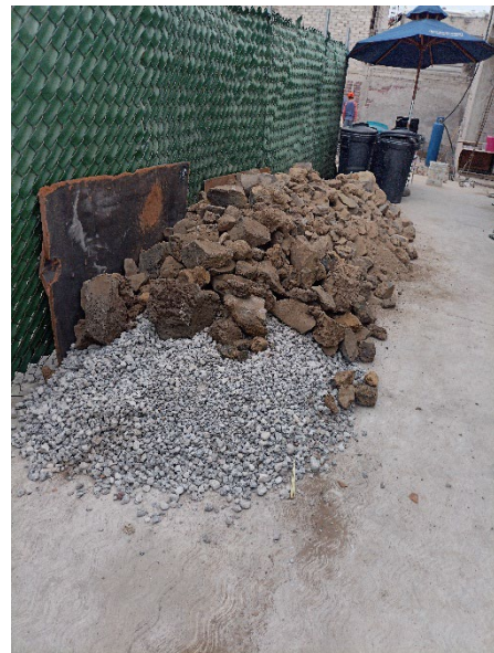
Imagen 2.- Foto de la grava y piedra para proceso de cimentación,
