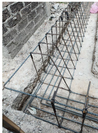
Imagen 4.- Armado de zapata con respecto a su detalle.
