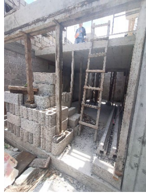
Imagen 21.- Foto de Planta baja y retiro de polines.
