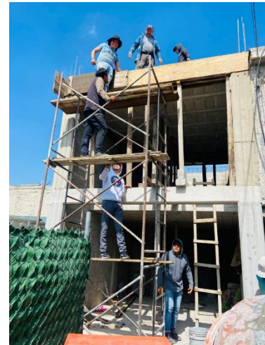
Imagen 28.- Foto de Boteo de azotea.
