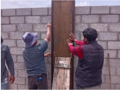
Imagen 23.- Foto de vaciado de columnas en PA.
