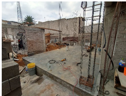
Imagen 7.- Foto del resultado de la cimentación.
