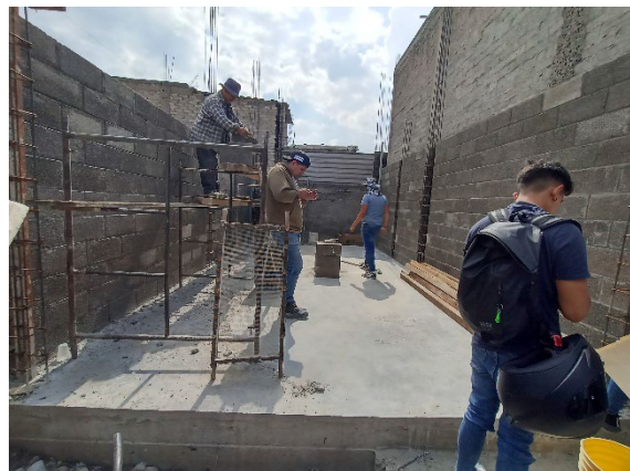
Imagen 10.- Foto del levantamiento de muros.
