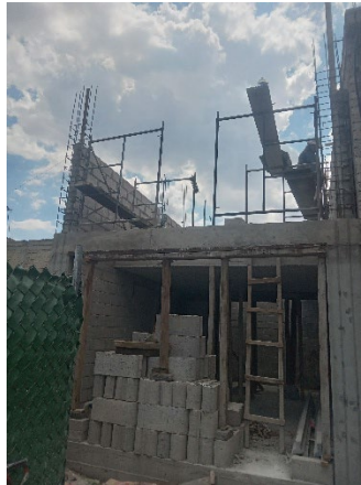
Imagen 24.-Vista de levantamiento de muros desde PB.
