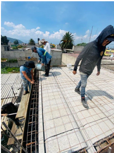
Imagen 26.- Foto de colado de azotea.
