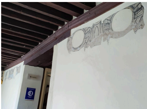
Imagen 24. Foto muro este, claustro
