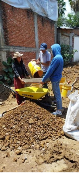
Figura 2. Proceso en el cual se cernía tierra para su uso en aplanado de fachada exterior. (Carla Rivera, 2022).
