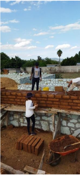
Figura 4. Proceso de colocación de los bloques de adobe para los muros que serán de la capilla para la comunidad de La Raya Zimatlán. (Carla Rivera, 2022).
