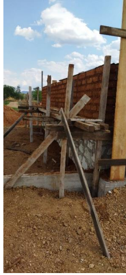
Figura 4. Proceso de colocación de los bloques de adobe para los muros que serán de la capilla para la comunidad de La Raya Zimatlán. (Carla Rivera, 2022).
