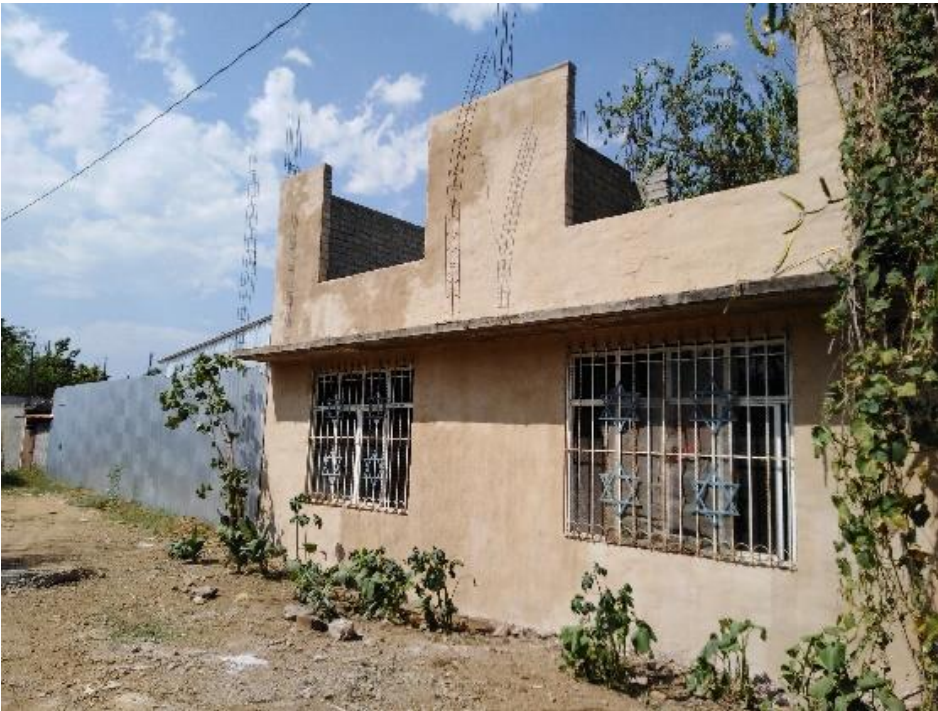
Figura 3. Finalización del aplanado de fachada exterior con tierra (Autoría propia, 2022).
