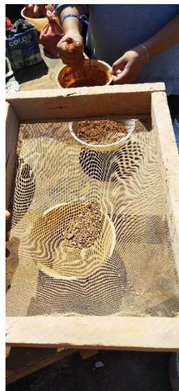
Figura 1. Proceso para preparar pintura de tierra sin cal para paredes exteriores. (Carla Rivera, 2022).
