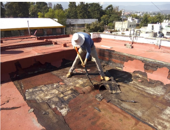
Ilustración 3 Visita a obras
