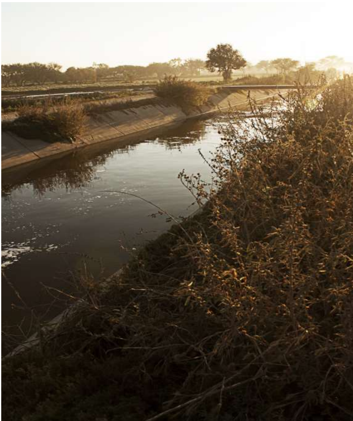
Canal de aguas negras en el Mezquital
