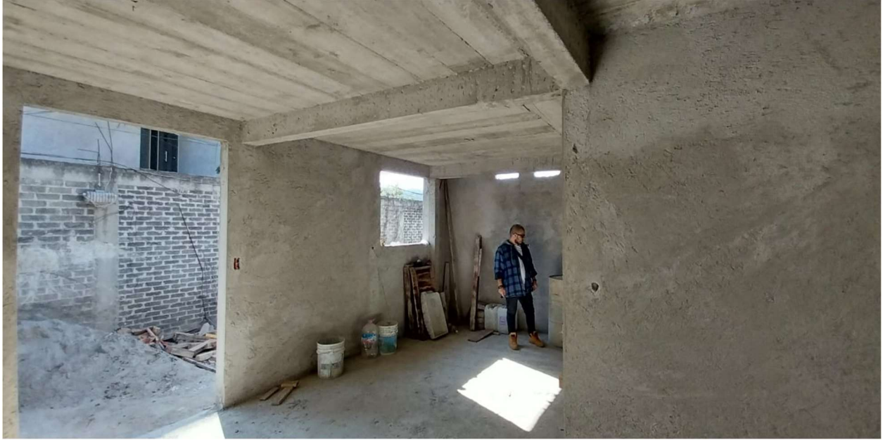
Imagen 15. Proyecto de vivienda en alcaldía Xochimilco, caso Guadalupe Morales. Visita de supervisión. Fuente: Fotografía propia.
