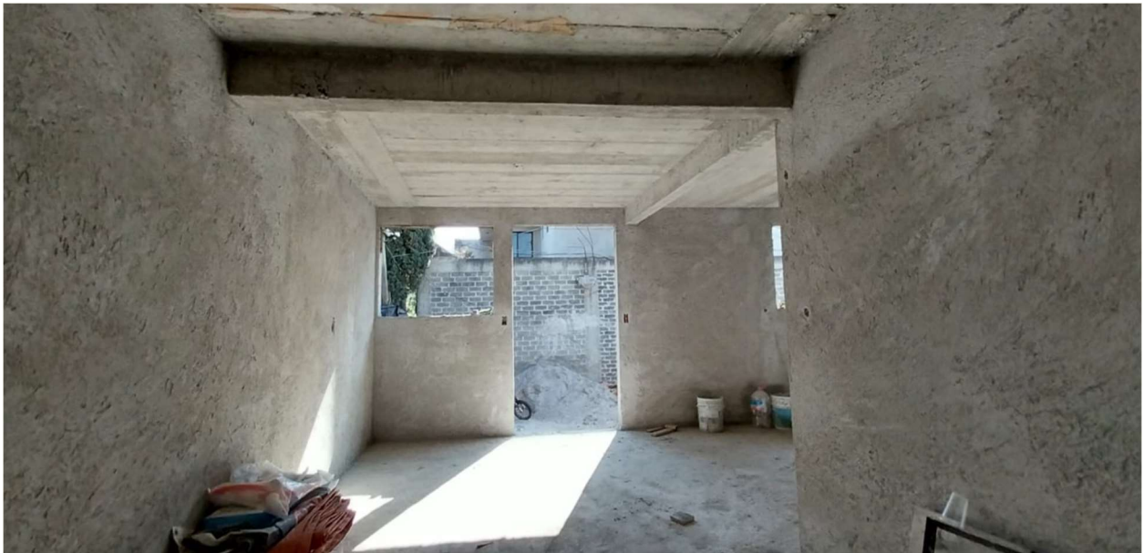
Imagen 16. Proyecto de vivienda en alcaldía Xochimilco, caso Guadalupe Morales. Visita de supervisión. Fuente: Fotografía propia.
