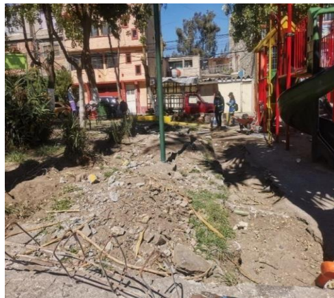
Ilustración 7: Reporte fotográfico del trabajo realizado en el retiro de material en el Parque Mezquite
