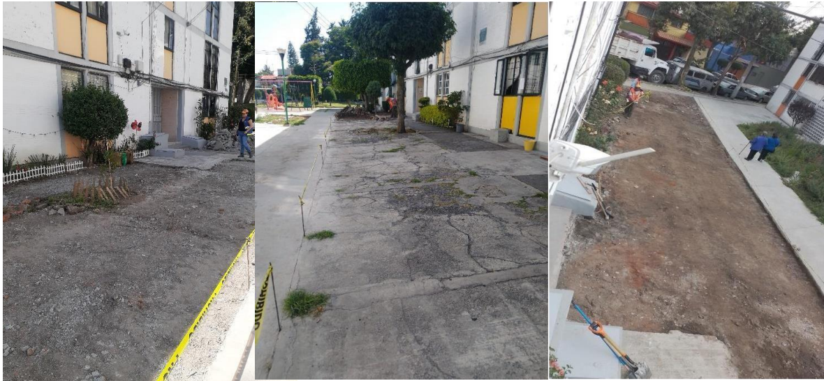
Ilustración 8: Levantamiento fotográfico del retiro de pavimentación en la unidad Habitacional Monte de Piedad.
