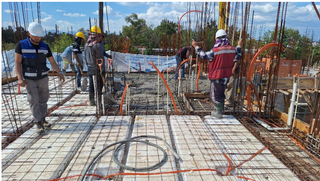
Imagen 11. Colado de losa de vigueta y bovedilla.
