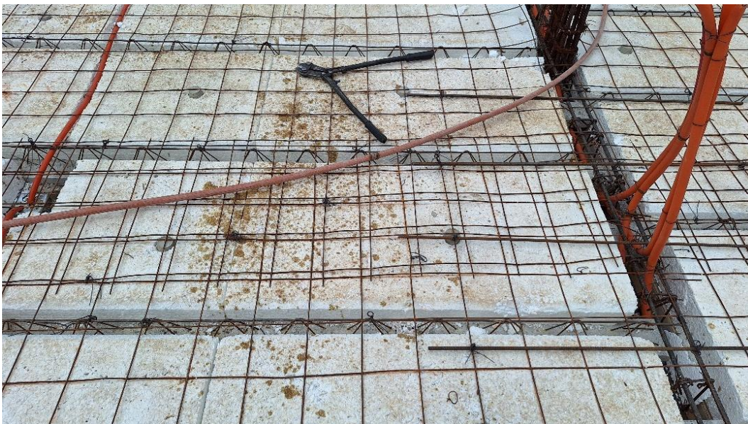
Imagen 10. Armado de losa de vigueta y bovedilla. Fuente: fotografía propia, 2025.
