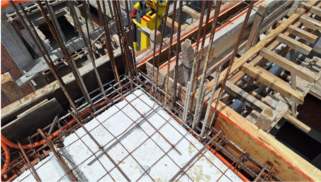
Imagen 7. Traslape de muro y anclaje a trabes. Fuente: fotografía propia, 2025.
