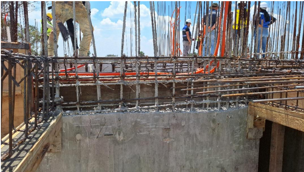
Imagen 8. Armado de trabe y anclaje a losa. Fuente: fotografía propia, 2025.
