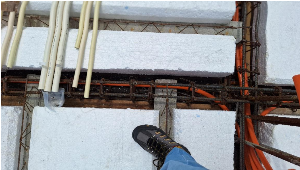
Imagen 9. Armado de dala y traslape de vigueta. Fuente: fotografía propia, 2025.
