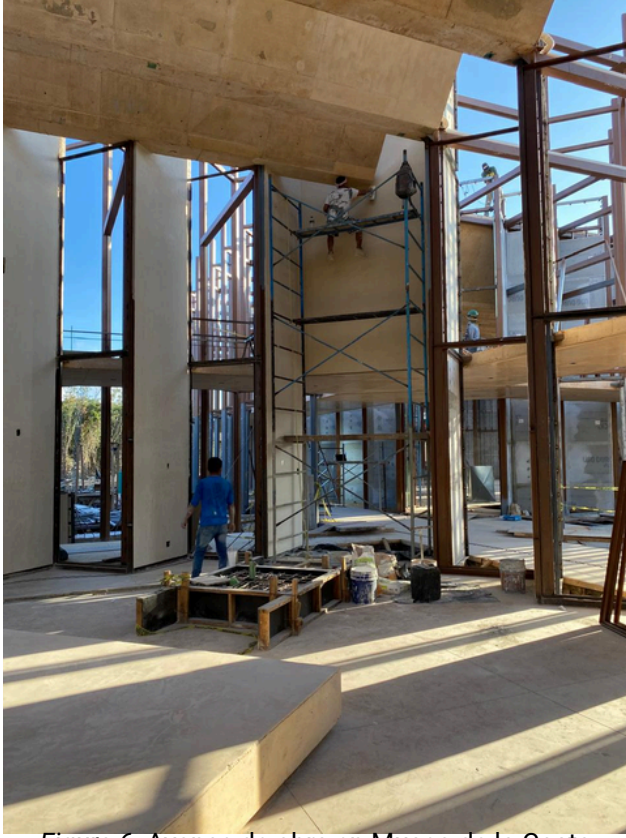
Figura 6. Avance de obra en Museo de la Costa Oriental, Tulum. (Febrero, 2024). Foto tomada por el autor.
