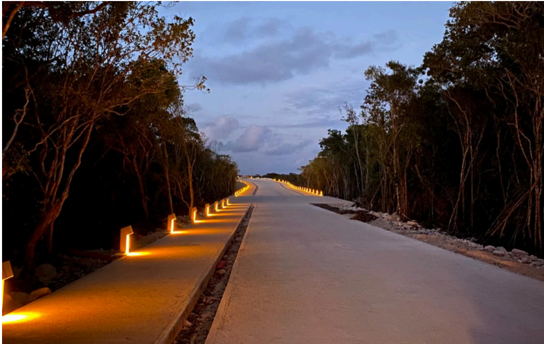
Figura 9. Construcción de vialidad en Parque El Jaguar. Tulum. (Abril, 2024). Foto tomada por el autor.
