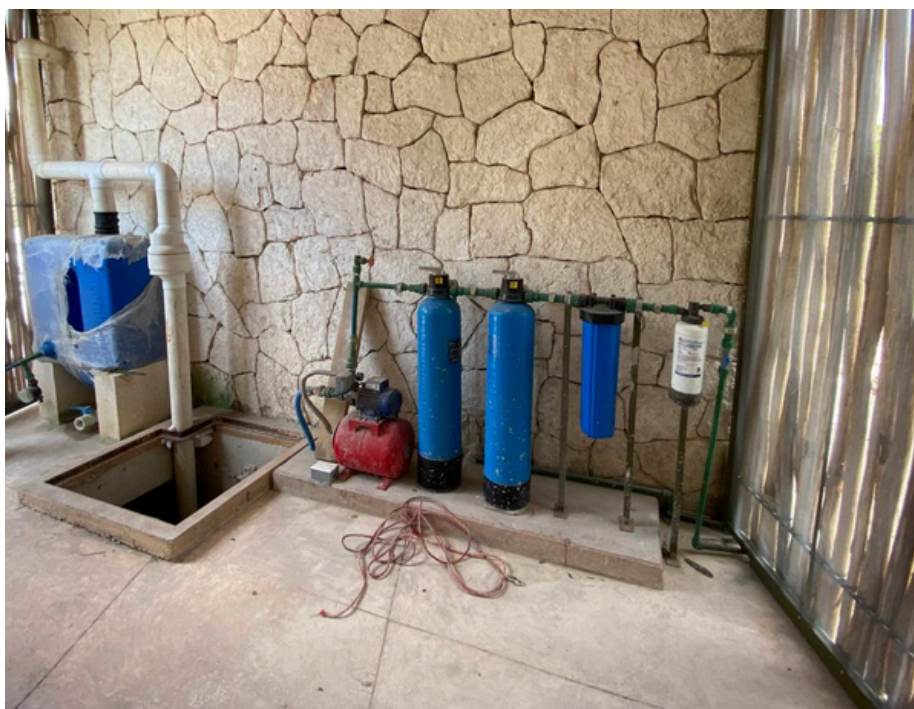
Figura 5. Sistema de captación y filtración de agua en Parque El Jaguar. Tulum. (Febrero, 2024). Foto tomada por el autor.
