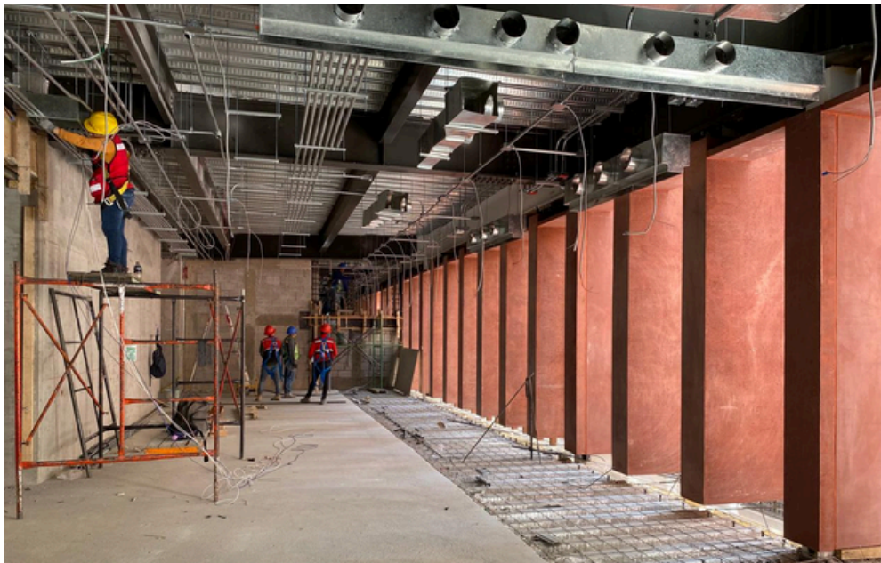
Figura 8. Avance de obra en Archivo General Agrario, CDMX. (Abril, 2024). Foto tomada por el autor.
