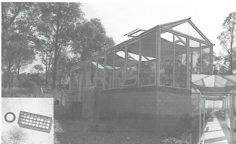
Anexo 16. O) Invernadero, instalaciones por fuera y por dentro. Fotografías propias.
