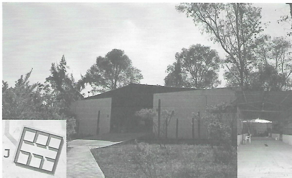
Anexo 12. J) Venadario, instalaciones por fuera y por dentro. Fotografías propias.
