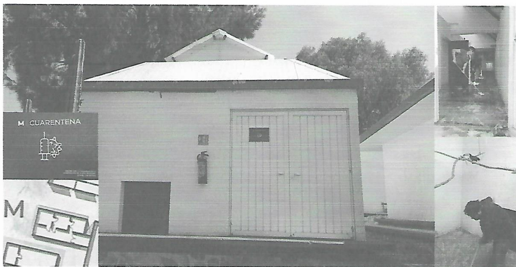
Anexo 15. M) Cuarentena, instalaciones por fuera y dentro, lavado de pasillo y cuarentena. Fotografías propias.
