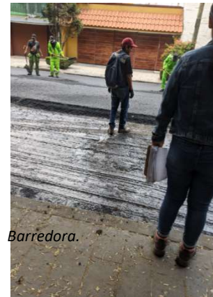
Aplicación de emulsión asfáltica.
