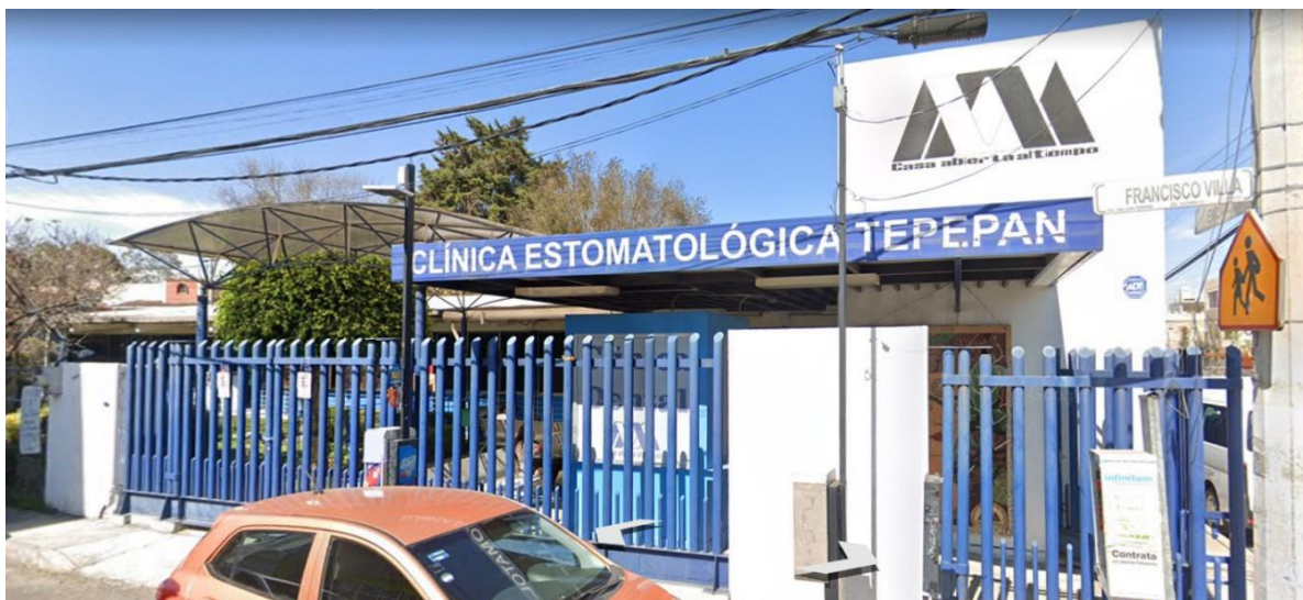
Figura 2. Instalaciones LDC Tepepan vista exterior.
