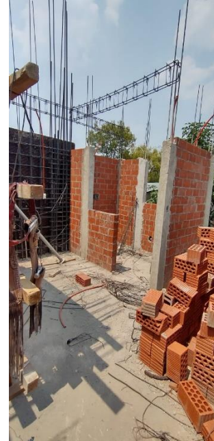
Anexo 7. Madrigal L. Adalid, 2024, fotografía de supervisión de enrase de muros de block "La Cruz".
