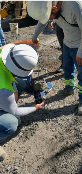
Anexo 3. Madrigal L. Adalid, 2024, fotografía de prueba de revenimiento en "Leyes de Reforma".
