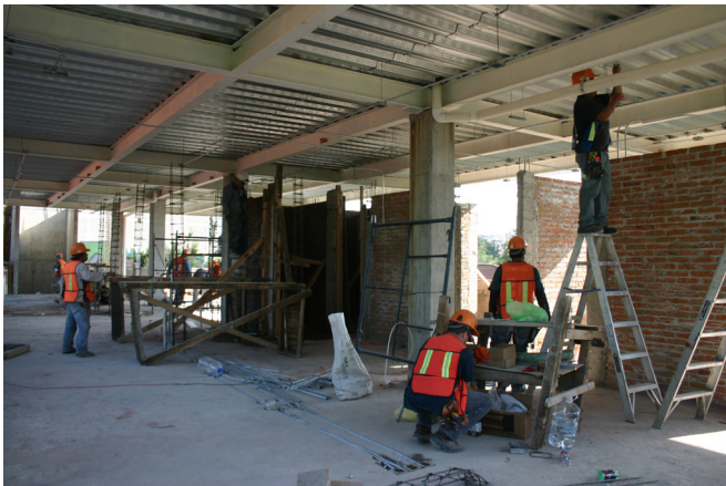
Fotografía 23. Electricistas colocando tubería conduit galvanizado en el primer nivel. 2015, Clínica Ampliación Presidentes.
