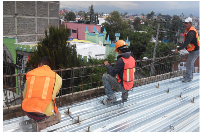
Fotografía 12. Armado del pretil. 2015, Clínica Ampliación Presidentes .
