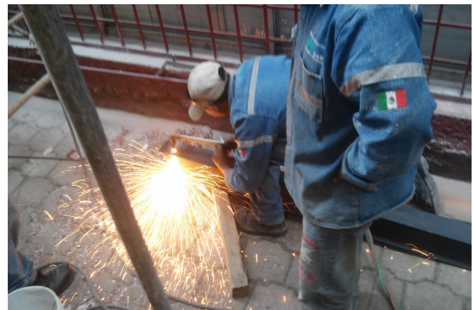
Fotografía 10. Corte y perforación de vigas de acero. 2015, Clínica Ampliación Presidentes .
