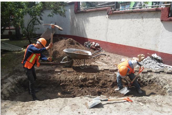
Fotografía 3. Excavación de la cepa para la cimentación de las escaleras y cubo del elevador. 2015, Clínica Ampliación Presidentes.
