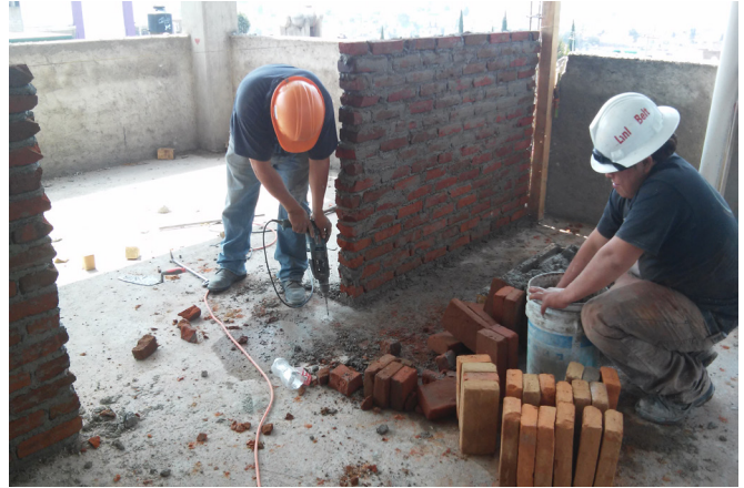
Fotografía 22. Levantamiento de muros y castillos del primer nivel. 2015, Clínica Ampliación Presidentes.
