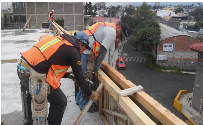
Fotografía 19. Cimbrado del pretil. 2015, Clínica Ampliación Presidentes .
