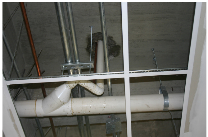
Fotografía 26. Colocación de tubería hidro-sanitaria en el entrespiso. 2015, Clínica Ampliación Presidentes.
