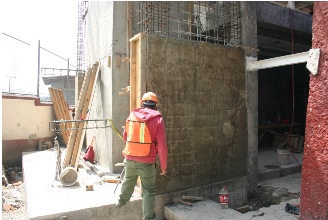
Fotografía 11. Descimbrado del muro de carga del cubo del elevador. 2015, Clínica Ampliación Presidentes .
