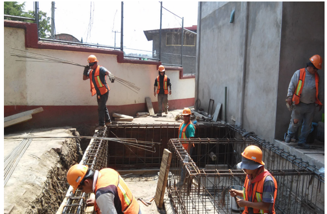
Fotografía 6. Armado de la cimentación para las escaleras y cubo de elevador. 2015, Clínica Ampliación Presidentes .
