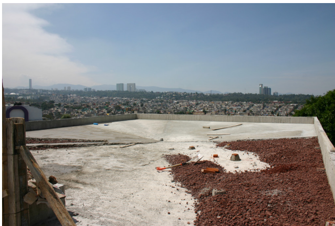
Fotografía 15. Entortado en la azotea. 2015, Clínica Ampliación Presidentes .
