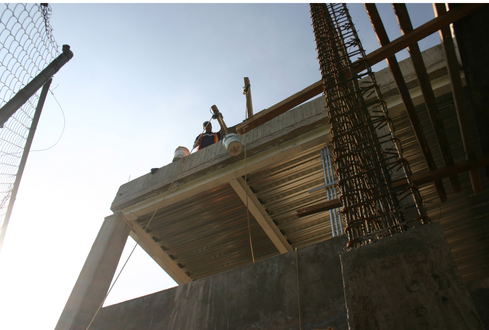
Construcción, 2015, Clínica Ampliación Presidentes.
