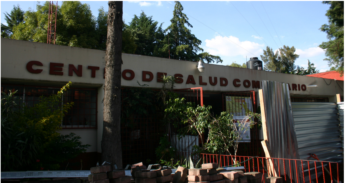
Fotografía 1. Fachada frontal. 2015, Clínica Ampliación Presidentes.
