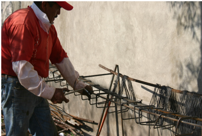
Fotografía 13. Armado de castillos. 2015, Clínica Ampliación Presidentes .
