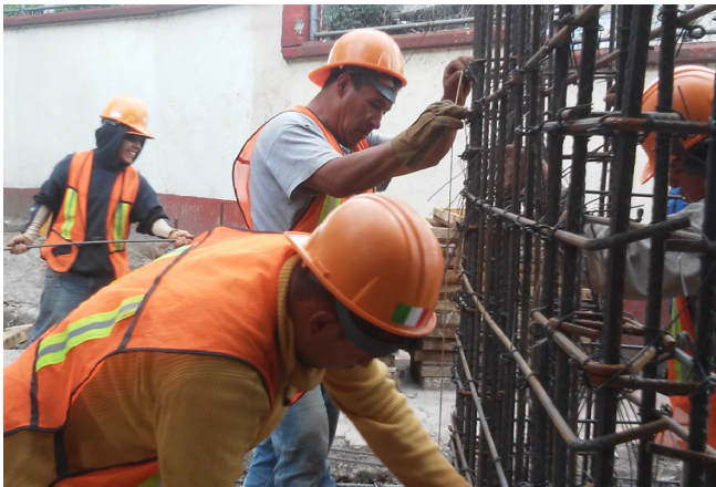
Fotografía 7. Armado del muro de carga para el cubo del elevador. 2015, Clínica Ampliación Presidentes .
