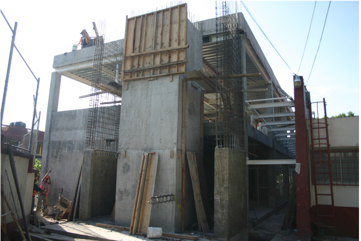
Fotografía 18. Vista del avance de la obra, descimbrado del muro de carga y pretil, mes de octubre. 2015, Clínica Ampliación Presidentes .
