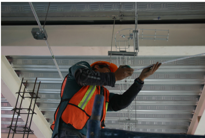
Fotografía 25. Colocación de equipo para la instalación eléctrica. 2015, Clínica Ampliación Presidentes.
