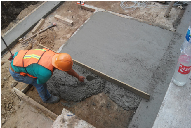
Fotografía 5. Colocación de plantilla para la cimentación para las escaleras y cubo del elevador. 2015, Clínica Ampliación Presidentes .
