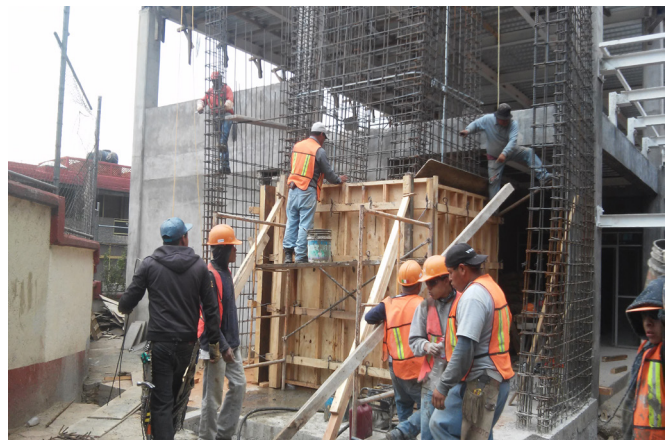
Fotografía 8. Cimbrado y colado del muro de carga del cubo del elevador. 2015, Clínica Ampliación Presidentes .
