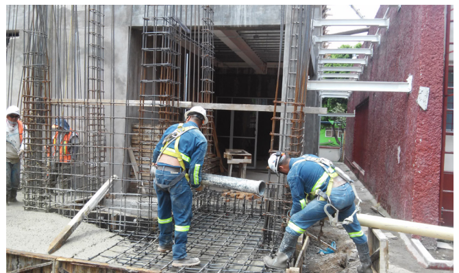
Fotografía 20. Colado de la losa del desplante de las escaleras. 2015, Clínica Ampliación Presidentes .
