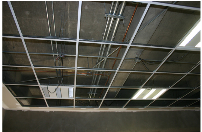
Fotografía 24. Tubería eléctrica en la planta baja 2015, Clínica Ampliación Presidentes.
