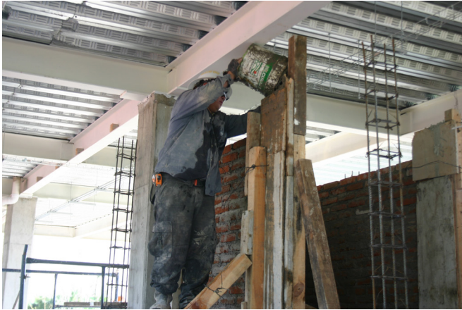
Fotografía 21. Colado de castillos de los muros divisorios del primer nivel. 2015, Clínica Ampliación Presidentes.
