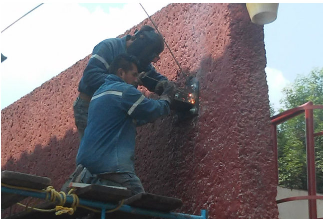
Fotografía 9. Herrería de la cubierta del pasillo entre ambas edificaciones, existente y nueva. 2015, Clínica Ampliación Presidentes .
