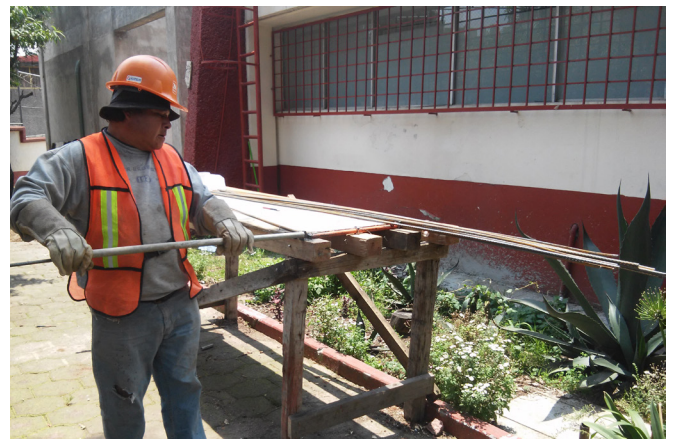
Fotografía 4. Corte y dobles de varilla para estribos. 2015, Clínica Ampliación Presidentes.
