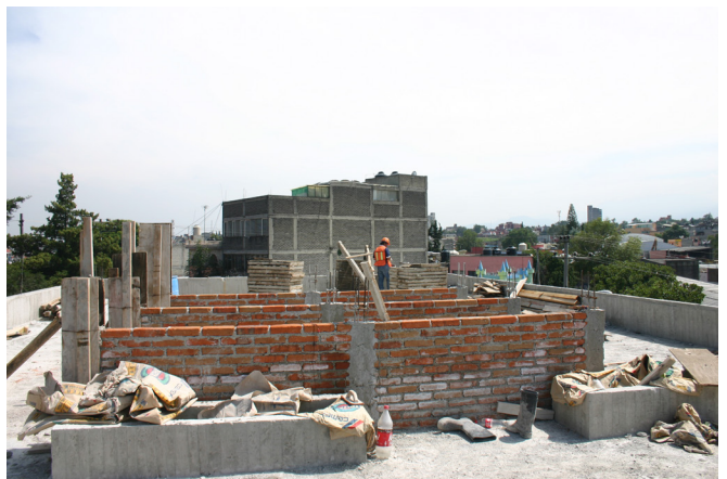
Fotografía 16. Levantamiento de muros y castillos para el soporte de los tinacos en la azotea. 2015, Clínica Ampliación Presidentes .
