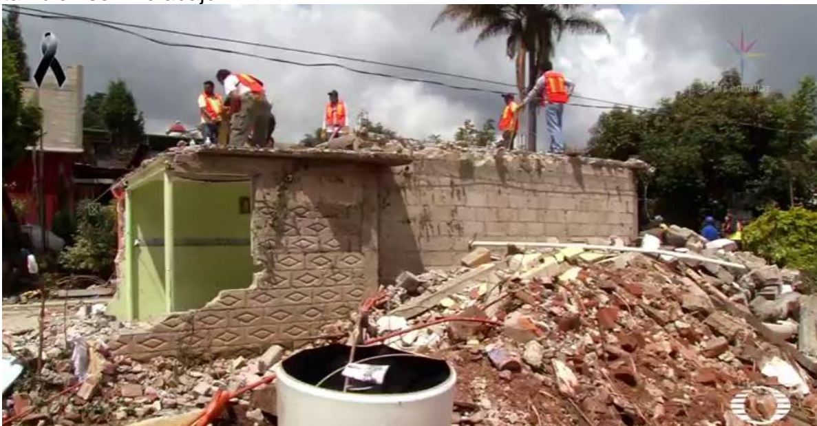
Fotografía 5a. Casa devastada en Tlatempa, Estado de México, por sismo del 19 de septiembre (Noticieros Televisa).
