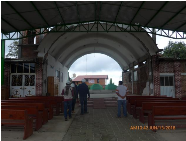
Fotografía 6a. Fachada interior
