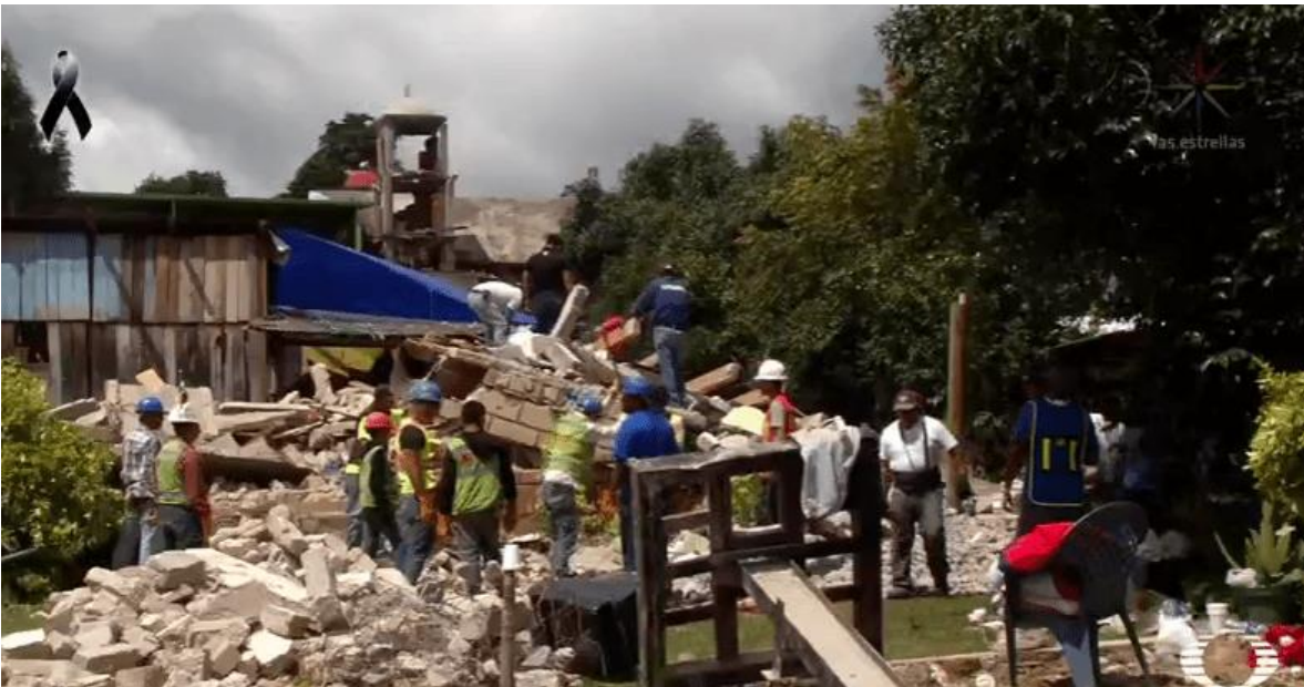
Fotografía 3a. Casa devastada en Tlatempa, Estado de México, tras el sismo del 19 de septiembre (Noticieros Televisa).
