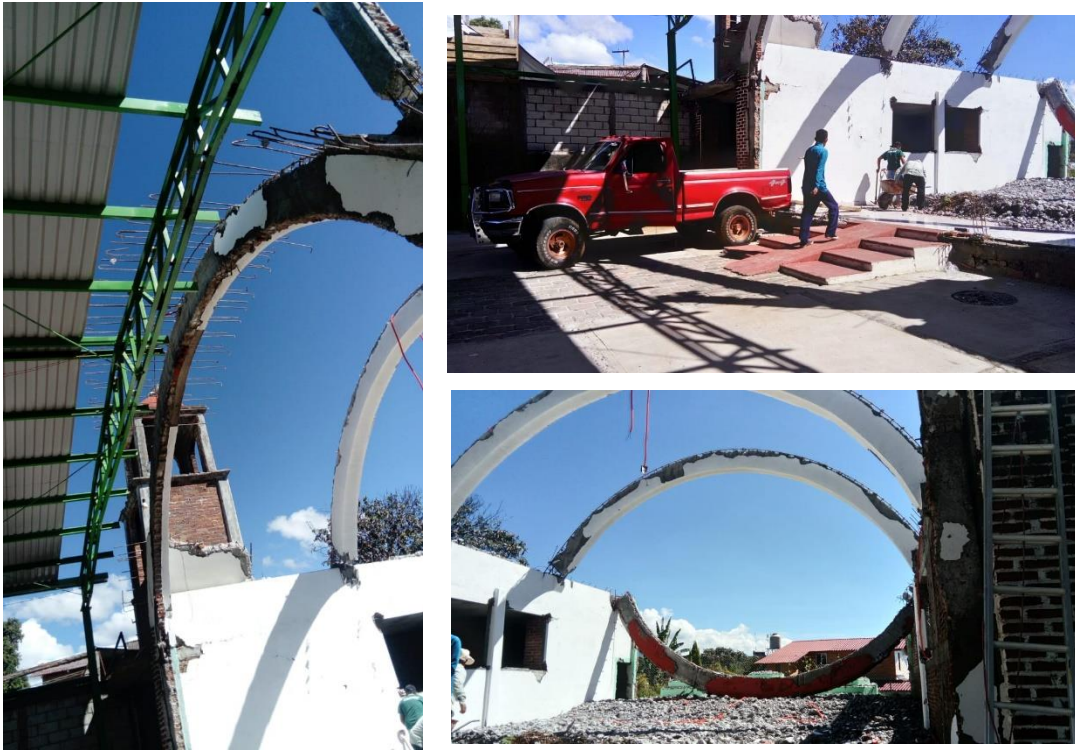
Fotografía 18a. demolición de capilla existente.
