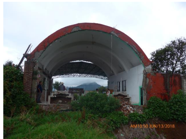
Fotografía 7a: Fachada Posterior
