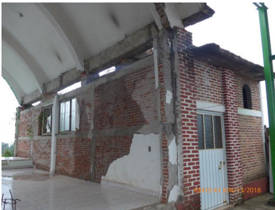
Fotografía 8a. Muro interior.
