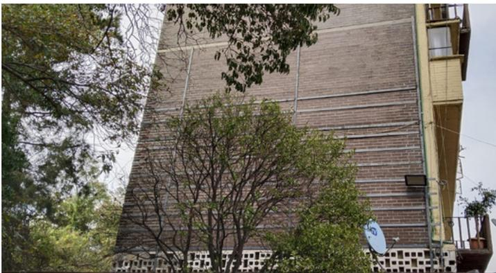
Fotografía 27. Reforzamiento de muros en fachada norte y sur del edificio, con un entramado de soleras y aplicación de pintura en este.
