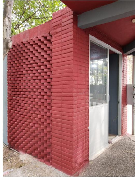
Fotografía 23. Resultado de aplicación de pintura en muro de tabique, en el cuarto de los vigilantes.
