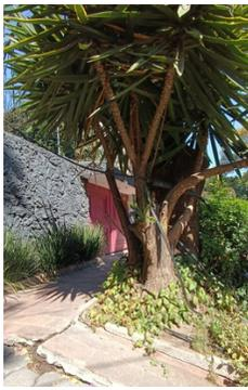
Fotografía 6. Visita en una calle en el centro de Coyoacán para determinar el grado de daño a la banqueta por las raíces de un árbol.
