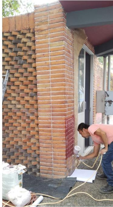
Fotografía 22. Proceso de aplicación de pintura en el muro de tabique rojo.
