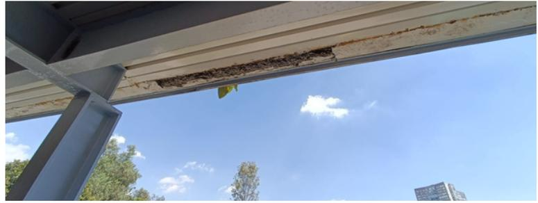
Fotografía 5. Foto tomada para verificar que las marquesinas estuvieran deterioradas para ver qué solución se daría.
