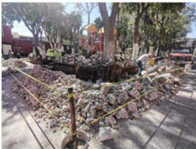
Fotografía 1. Parque Amezquite, visita al sitio, ya había un avance del concepto de demoler dos de sus muros perimetrales.
