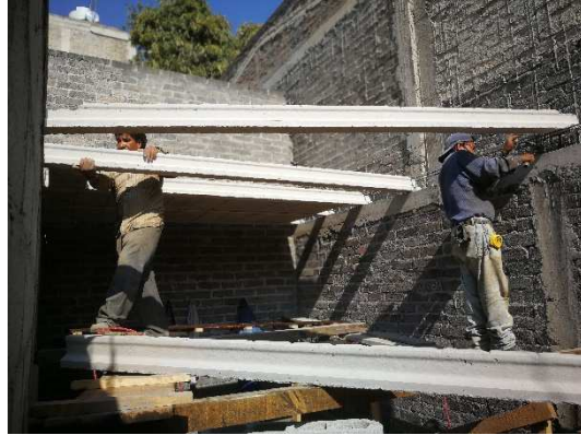
Ilustración 8 Colocación de vigueta y bovedilla en obra
