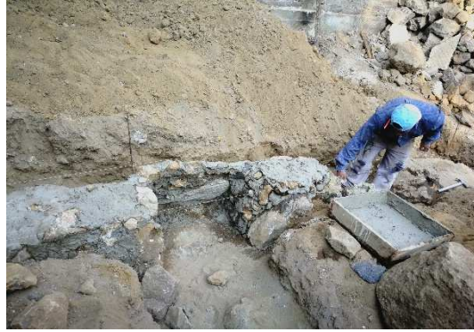
Ilustración 4 Junteado de piedras para zapata corrida
