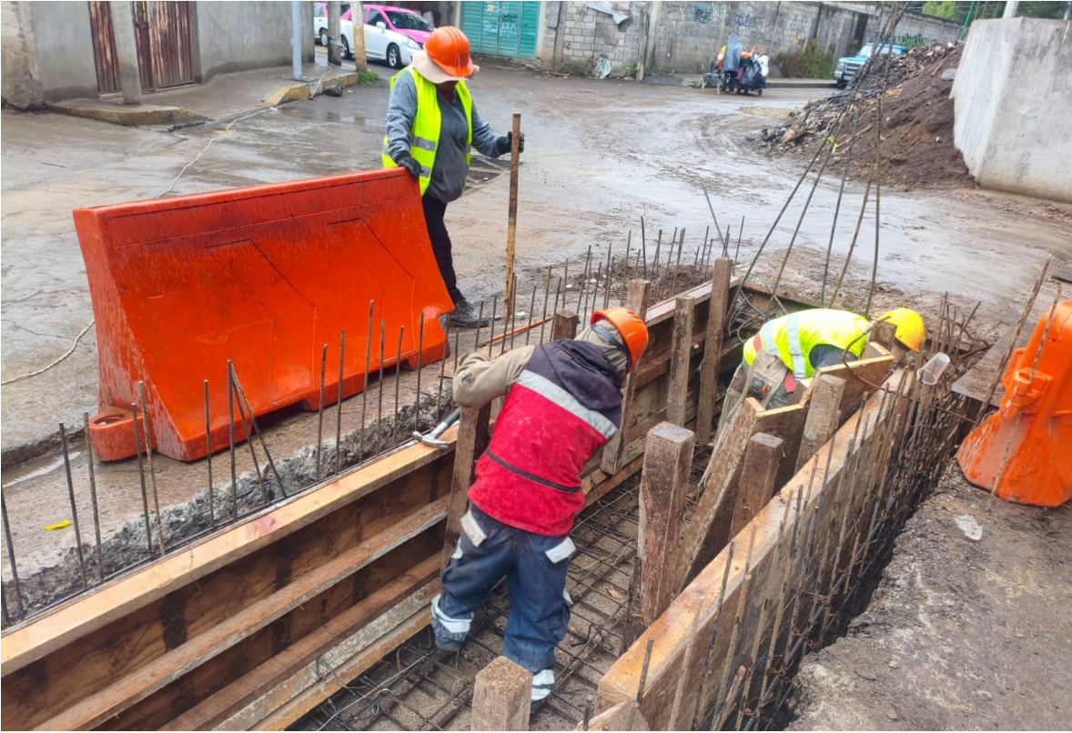
4. Visita al sitio de trabajo, trabajos de colocación de cimbra para recibir colado
