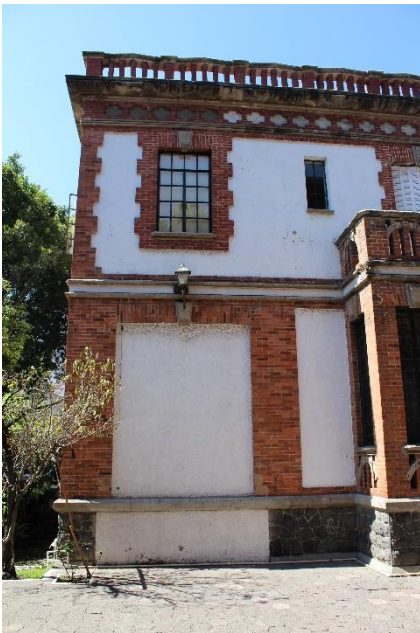
IMAGEN 14. Levantamiento fotográfico de ladrillo en la Colonia Roma, lado izquierdo
