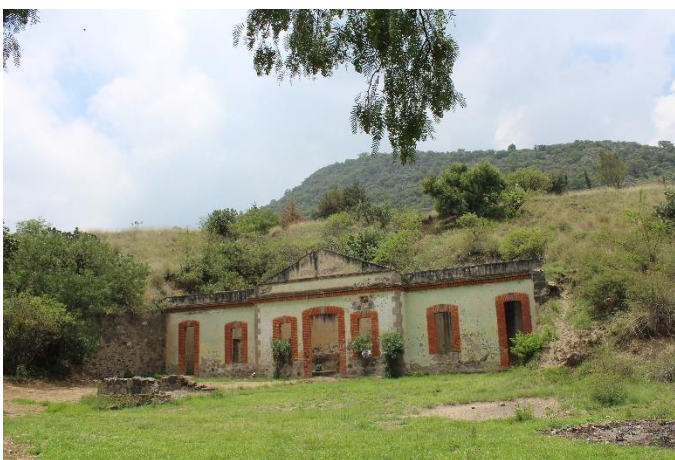
IMAGEN 4. Ex-Hacienda "Molino de Flores", proyecto de restauración, estado actual del inmueble.
