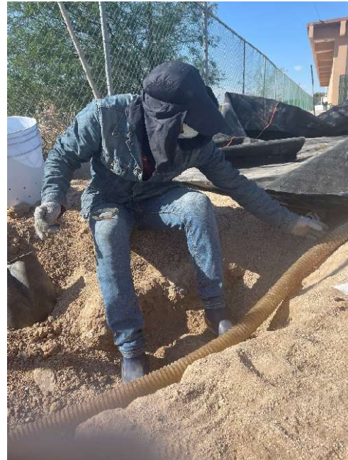
Instalación de tuberías
