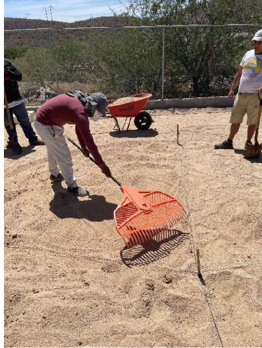
Nivelación de patio
