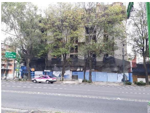
Imagen 7. Reporte fotográfico. Construcción de edificio departamental en colonia Independencia. 1
