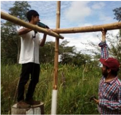
Primeras fases de construcción
