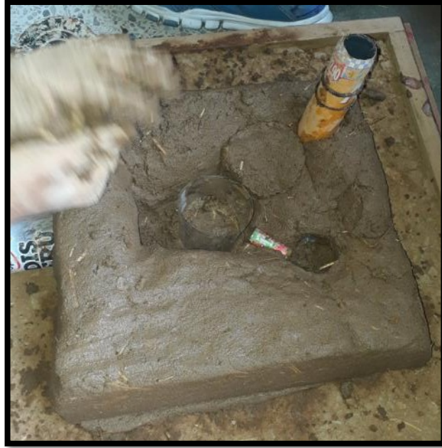
Imagen 27 "Molde interno de la cámara principal"
