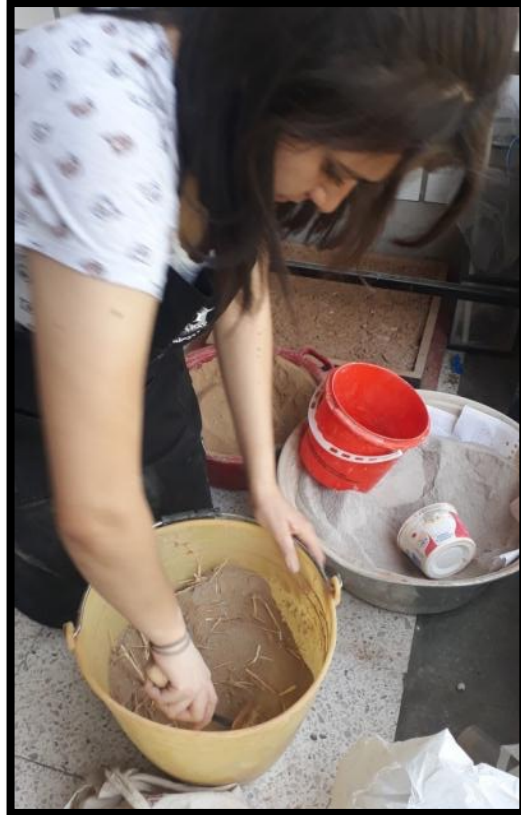
Imagen 19 "Agregado de paja para un mejor aglutinamiento"
