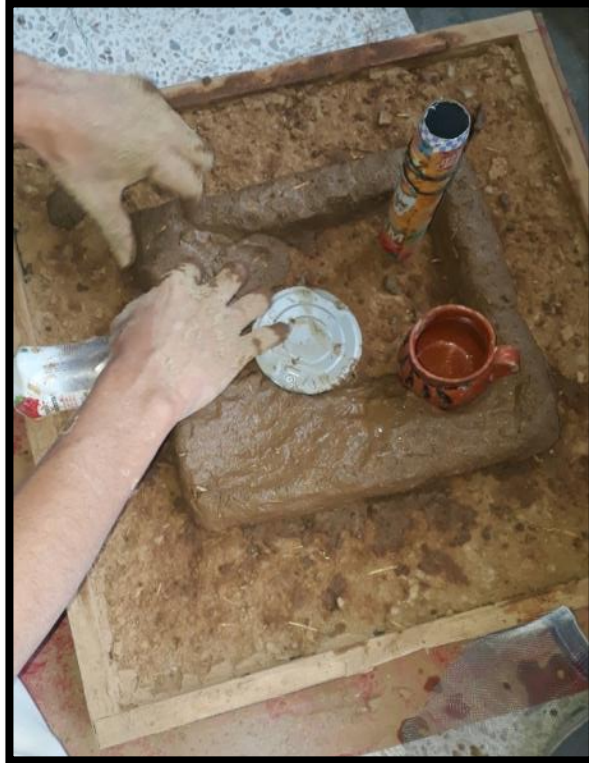
Imagen 25 "Inicio de la estufa y colocación de los conductos"
