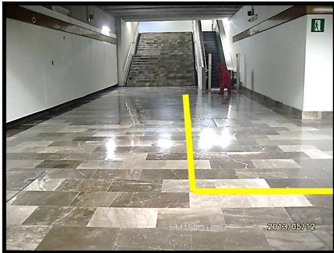
ESTACION MIXCOAC: FALTA LA INSTALACION DE LA GUIA TACTIL PARA INVIDENTES EN EL VESTIBULO Y ACCESO
