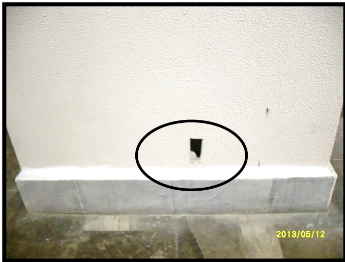
ESTACION ERMITA: FALTA LA INSTALACION DE CONTACTOS ELECTRICOS EN LOS ANDENES
