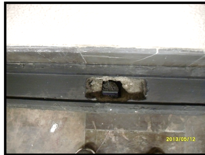
ESTACION EJE CENTRAL: FALTAN LAS REJILLAS Y LA INSTALACION DEL ZOCLODREN EN LOS ANDENES
