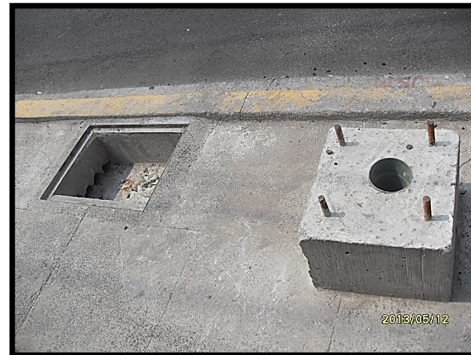
ESTACION MEXICALTZINGO: NO SE INSTALARON LAS LAMPARAS LUMINOSAS DE CADA ACCESO A LA ESTACION
