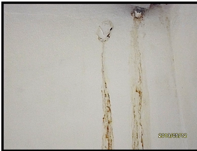
ESTACION ATLALILCO SE DETECTAN FILTRACIONES EN DIFERENTES AREAS DE LA ESTACION
