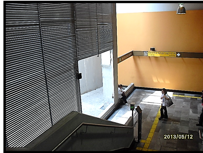
ESTACION ERMITA: FALTA LA COLOCACION DE MAMPARAS EN EL RESPIRADERO
