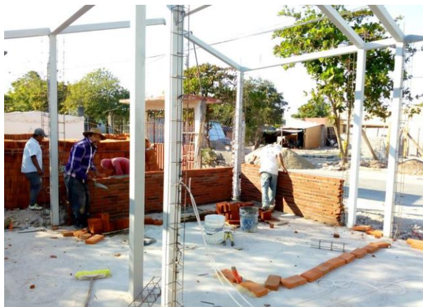
Fotografía 5- Muros de mampostería
