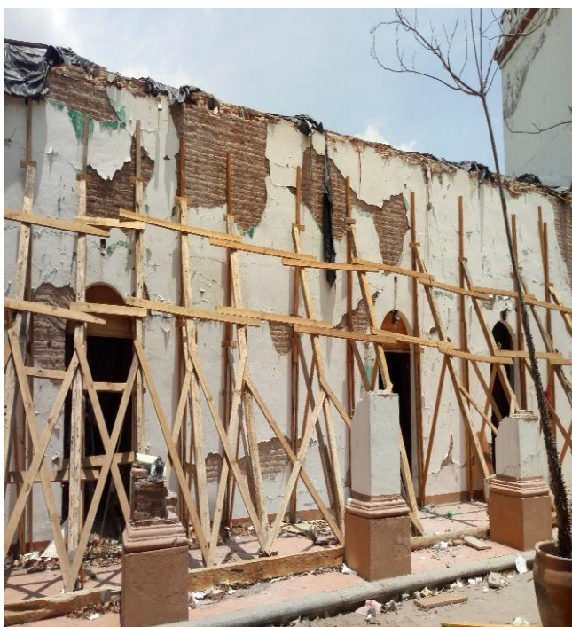
Fotografía 23. Apuntalamiento de muros
