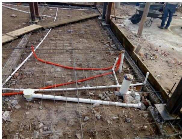
Fotografía 2. Preparación de instalaciones
