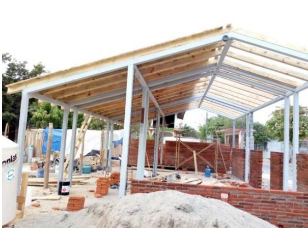
Fotografía 6. Colocación de cubierta
