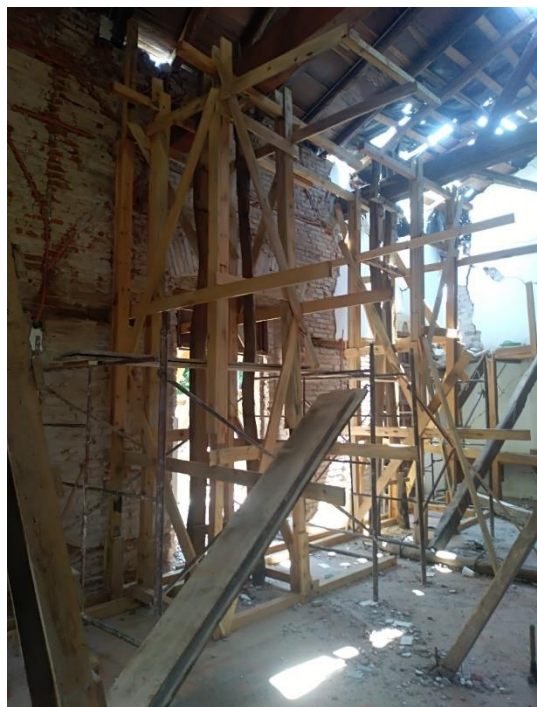
Fotografía 22. Apuntalamiento de cubierta
