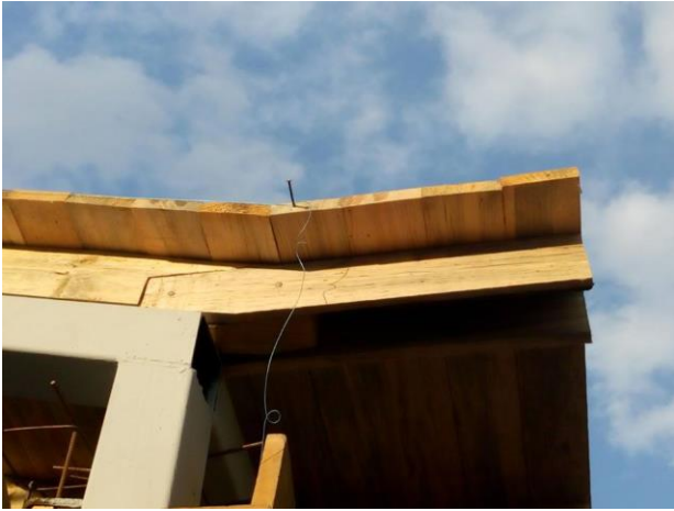
Fotografía 7. Detalle de madera de cubierta
