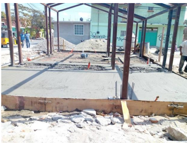
Fotografía 4. Colado de losa de cimentación
