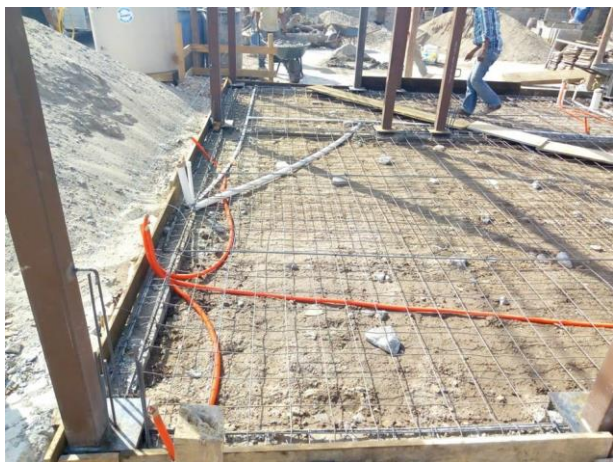
Fotografía 1. Preparación para colado de losa
