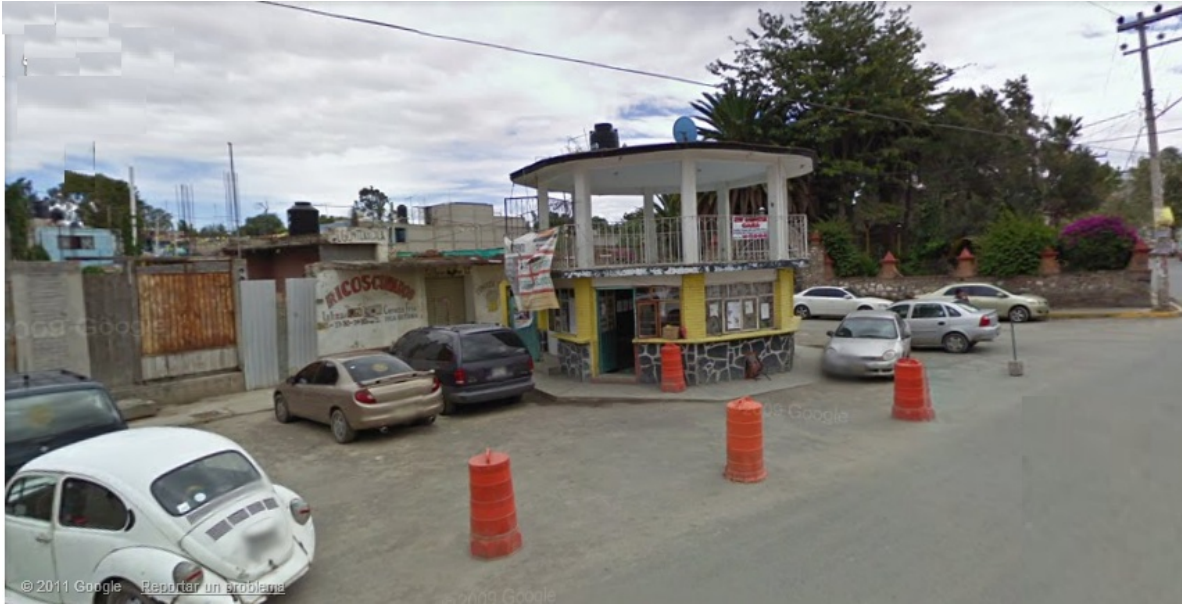
Estado de la plaza antes de la intervención.
