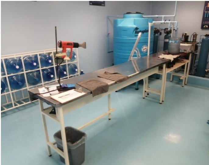
Anexo 16: Espacios de trabajo
