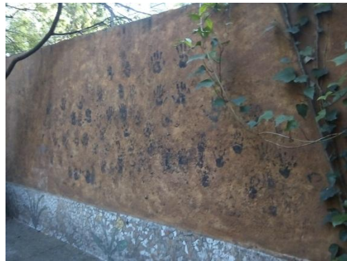
Muro de pintura con tierra
