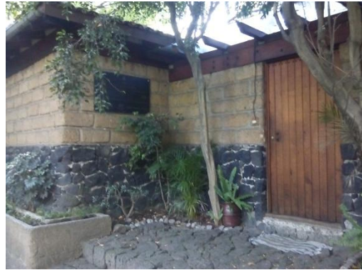
Muro de tepetate, cimentación de piedra brasa
