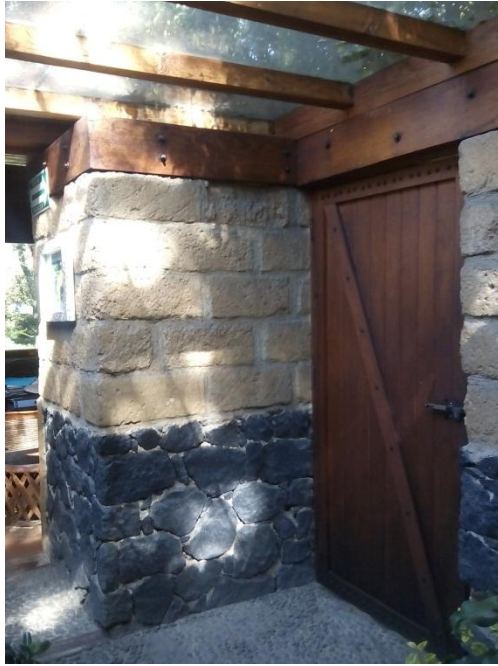
Dalas, vigas y puerta de madera
