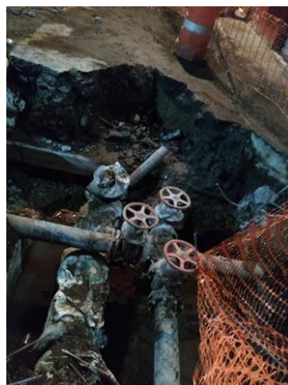
Foto 2. Red de agua potable, calle Pedro Ramírez del Castillo.
