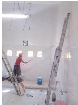
Fig. 5 Aplicación de pintura dentro de los baños.
