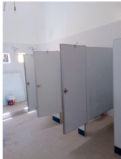
Fig.10 Paneles de Porce Wall nuevos colocados en los sanitarios.
