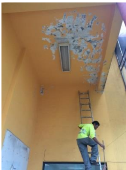
Fig. 4 Obrero resanando para poder aplicar pintura.
