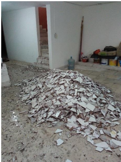
Fig. 7 Demolición por medios manuales de loseta cerámica vieja.
