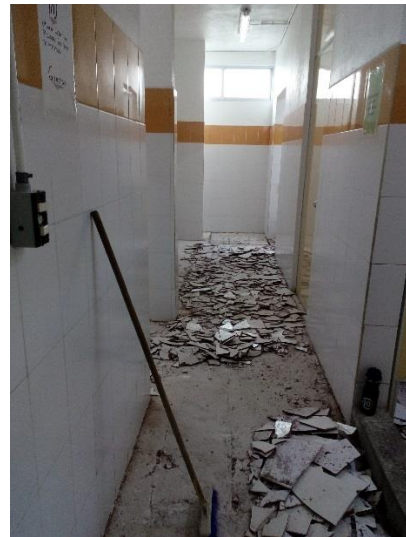
Fig. 8 Demolición por medios manuales de loseta cerámica vieja.
